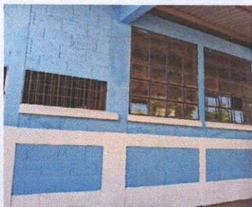
FOTO 7: PINTURA (pintura de muros exteriores e interiores)
