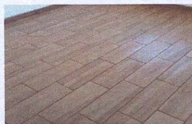
FOTO 6: PISO (sustitución de piso cerámico)
