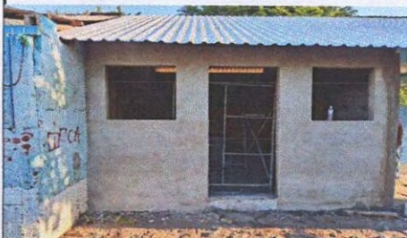
FOTO 9: REPARACIÓN DE REPELLO Y CERNIDO DE PAREDES (repello en muro)
