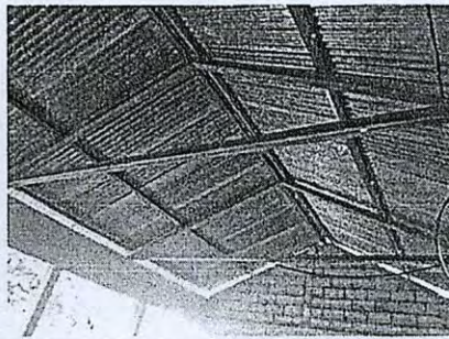
FOTO 2: ESTRUCTURA DE TECHO (sustitución de estructura de soporte de metal, por metal)
