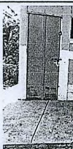
FOTO 3: PUERTA DE METAL (Mantenimiento a estructura (lijado, cambio de tubo, cepillado, sujeción, aplicación de pintura)
