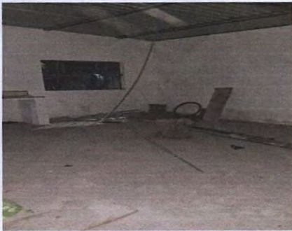
Foto 3: 6.8 Sustitución de piso cerámico en la cocina
