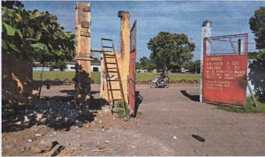
Foto 1: 4.5 Sustitución de porton de metal
