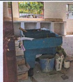
Foto 15: 20.10 Sustitución de pila de cemento de dos lavaderos.
