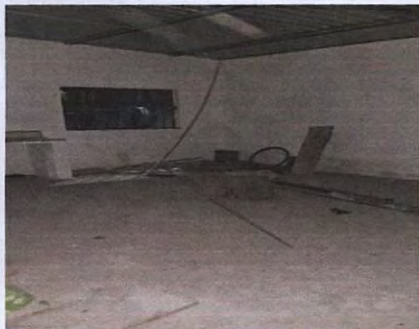
Foto 3: 6.8 Sustitución de piso cerámico en la cocina
