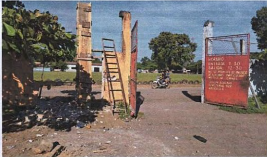
Foto 1: 4.5 Sustitución de porton de metal
