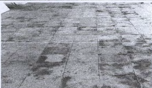
Foto 3: 6.5 Sustrucción de piso de torta de concreto en corredor de piso de aulas a la par de direccón
