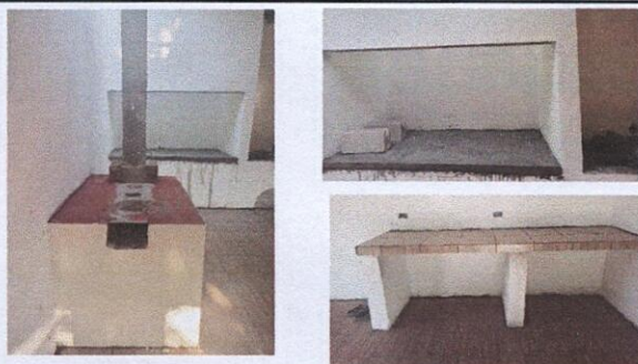
Foto 9: REPARACIÓN DE COCINA: Sustitución de estufa rural y pila
