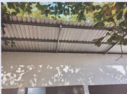
Foto 1: CUBIERTA DE LAMINA: Sustitución de lámina y elementos de fijación
