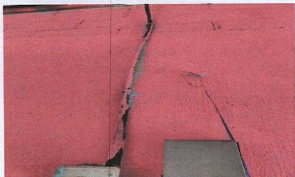
Foto 15: 17.12 Sustitución de ducto eléctrico + accesorios cocina
