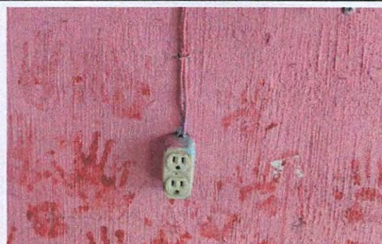
Foto 12: 17.8 Sustitución de tomacorrientes dobles cocina
