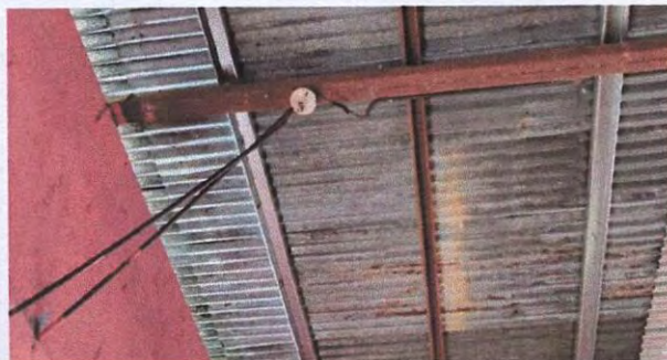
Foto 14: 17.11 Reparación de cableado eléctrico cocina
