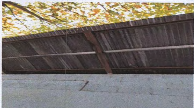
Foto 1: 1.1 Sustitución de lámina, por lámina troquelada aluzinc calibre 26 cocina
