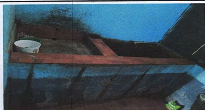
Foto 17: 20.10 Sustitución de pila de cemento de dos lavaderos
