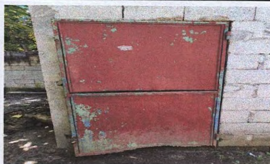
Foto 4: 4.3 Sustitución de puerta en bodega
