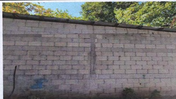
Foto 18: 21.1 Repello en muro en cocina
