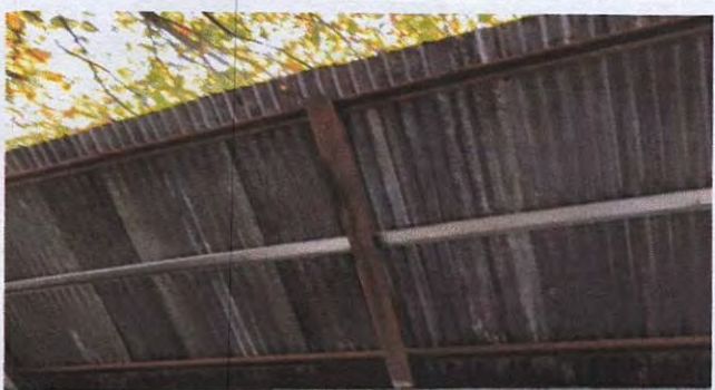
Foto 3: 2.3 Sustitución de estructura de soporte de metal, por metal en cocina
