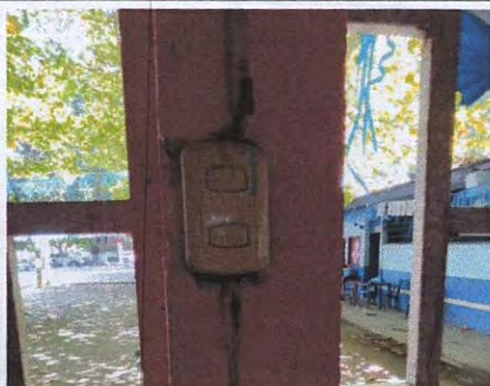
Foto 11: 17.7 Sustitución de interruptores dobles cocina
