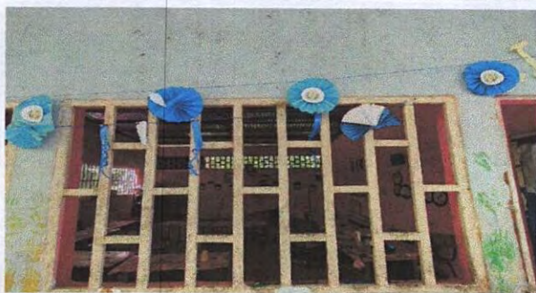
Foto 5: 5.2 Sustitución de estructura de metal de ventana cocina
