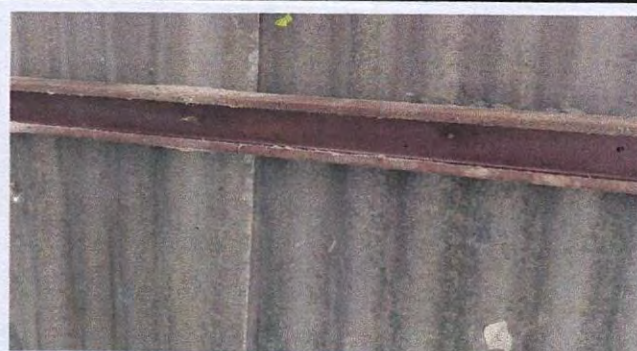
Foto 2: 1.3 Sustitución de elementos de fijación cocina
