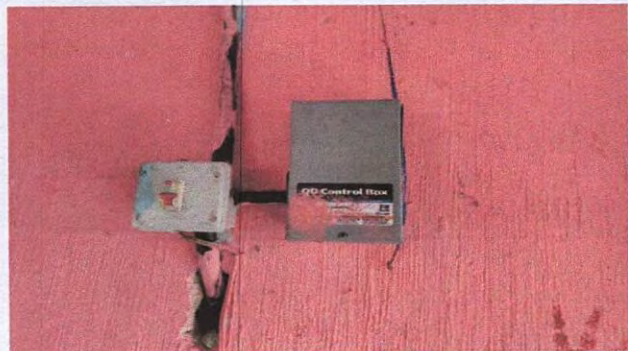
Foto 13: 17.10 Sustitución de tablero de flípones cocina
