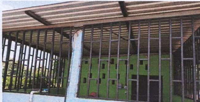
Foto 4: 5.6 Sustitución de balcones de metal en cocina
