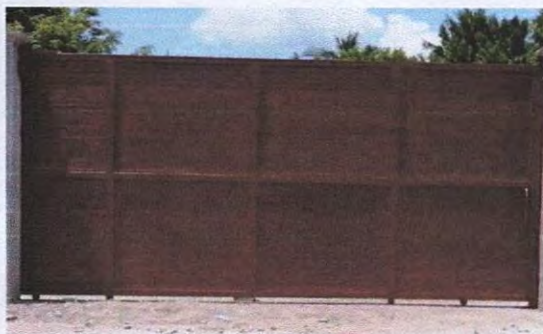
Foto 3: 4.5 Sustitución de portón de metal
