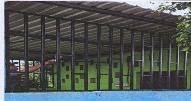
Foto 4: 5.6 Sustitución de balcones de metal en cocina
