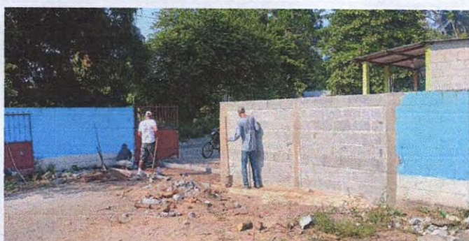
Foto 3: 4.5 Sustitución de portón de metal
