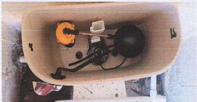
Foto 7: 10.2 Sustitución de accesorios inodoro (contra llave, tubo de abastoy tanque
