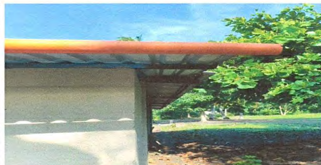
Foto 8: 7.2 Sustitución de canal de pvc en comedor
