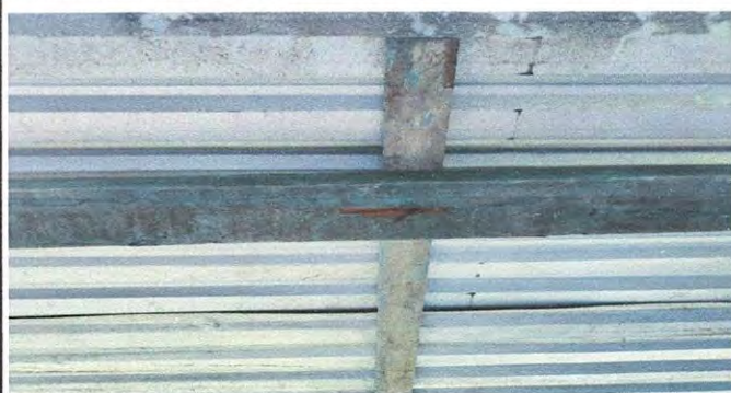
Foto 4: 2.2 Sustrucción de estructura de soporte de madera, por metal en aulas y comedor
