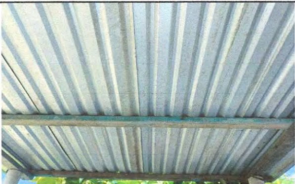
Foto 1: 1.1 Sustrucción de lamina, por lamina troquelada aluzinc callibre 26 en aulas y comedor.
