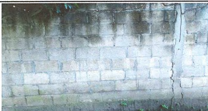
Foto 11: 21.1 Repello en muro comedor
