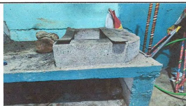
Foto 10: 20.2 Sustitución de estufa rural (completa) incluye chimenea y plancha de metal
