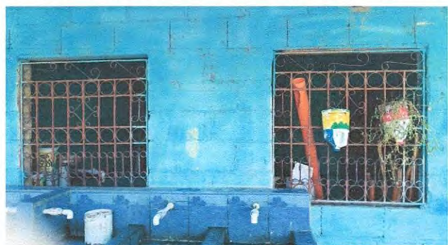
Foto 7: 5.6 Sustitución de balcones de metal cocina
