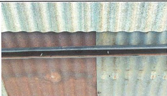
Foto 3: 1.3 Sustrucción de elementos de fijación en aula y comedor
