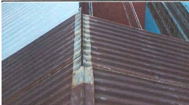
Foto 2: 1.2 Sustrucción de capote de lámina para lámina troquelada en cocina
