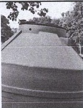
Foto 7: 18.2 Sustitución de deposito de agua 1100 lt
