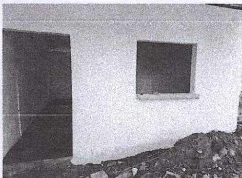
Foto 3: 4.3 Sustitución de puerta
