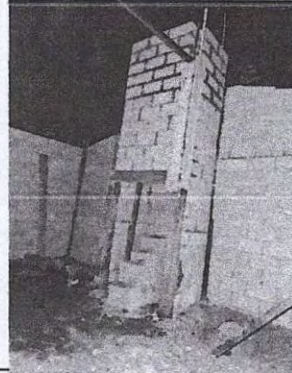
Foto 8: 20.2 Sustitución de estufa rural completa
