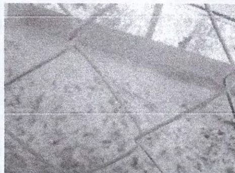
Foto 4: 6.1 Reparación de piso de torta de concreto
