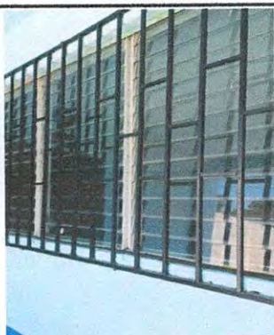
Foto 3: VENTANAS 5.1 mantenimiento estructura de metal de ventana
