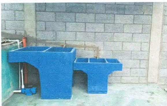
Foto 13. INSTALACION DE PILA. 19.2 Instalacion de pila
