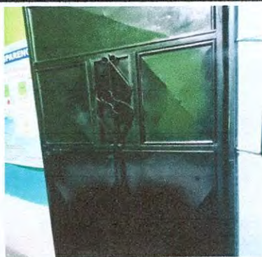
Foto 1: PUERTAS DE METAL: 4.1 Mantenimiento a estructura (lijado, cambio de tubo, cepillado, sujetaciones, aplicación de pintura)
