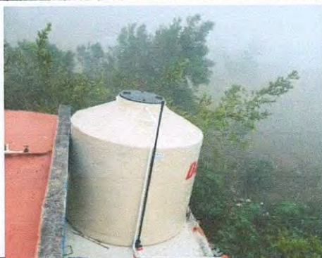
Foto 10. REPARACION Y MANTENIMIENTO DE CISTERNA/DEPOSITO DE AGUA 18.3 Sustitucion de deposito de ago 1700lt.
