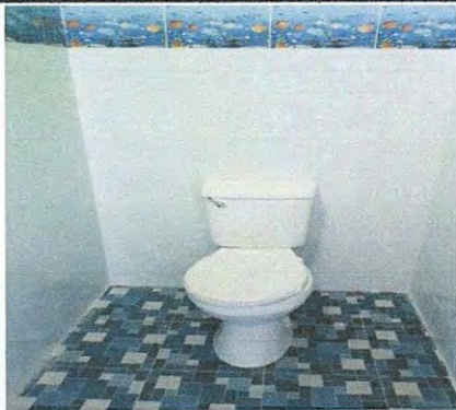
Foto 06: SERVICIOS SANITARIOS. 10.3 Sustitución de inodoro
