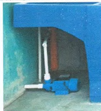
Foto 11: REPARACION Y MANTENIMIENTO DE CISTERNAS Y DEPOSITO DE AGUA. 18.3 Sustitucion de bomba de agua
