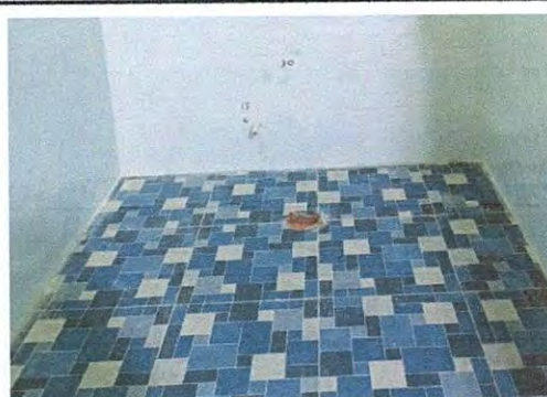
Foto 4: PISO 6.7 sustitución de piso de granito
