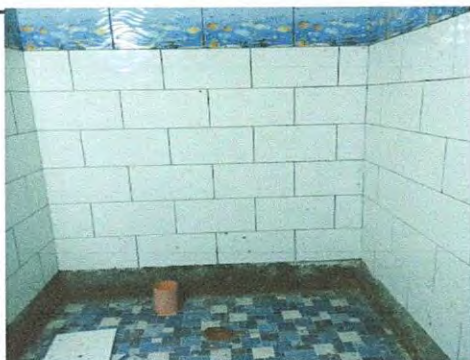
Foto 08: SUSTITUCION DE AZULEJO. 13.1 Sustitucion de azulejo
