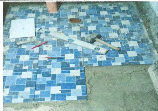
Foto 4: PISO 6.7 sustitución de piso de granito
