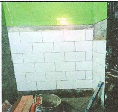
Foto 08: SUSTITUCION DE AZULEJO. 13.1 Sustitucion de azulejo
