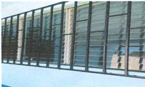
Foto 3: VENTANAS 5.1 mantenimiento estructura de metal de ventana
