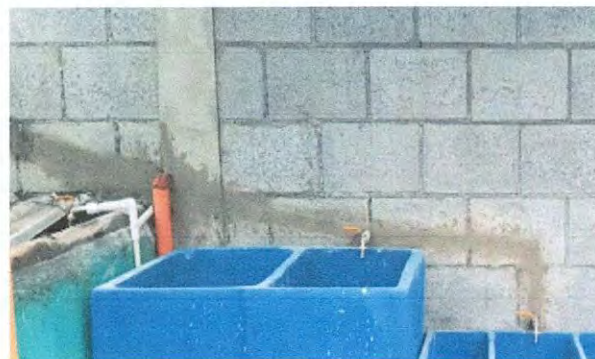
Foto 09. REPARACION DE RED DE DERENAJE Y RED DE AGUA POTABLE. 14.13 Sustitución de llave de chorro
