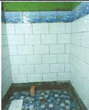
Foto 06: SERVICIOS SANITARIOS. 10.3 Sustitución de inodoro
