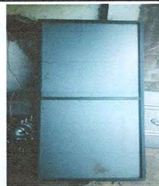
Foto 2: 4.4 Sustitución de puerta en servicio sanitario
