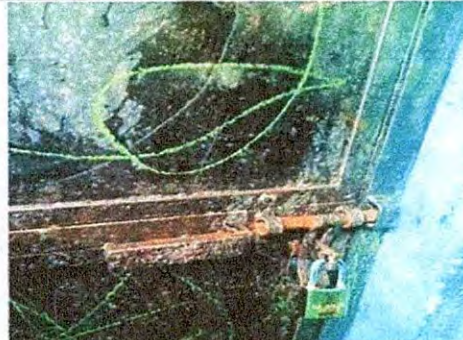
Foto 2: Sustitución de chapa. 4.2
