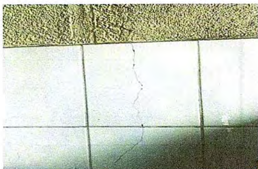
Foto 08: SUSTITUCION DE AZULEJO. 13.1 Sustitución de azulejo.
