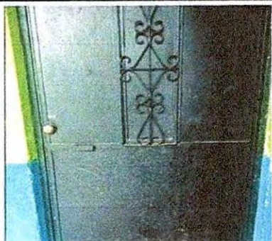
Foto 1: PUERTAS DE METAL 4.1. Mantenimiento a estructura (lijado, cambio de tubo, cepillado, sujetaciones, aplicación de pintura)
