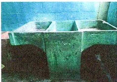
Foto 13: INSTALACION DE PILA. 19.2 Instalacion de Pila
