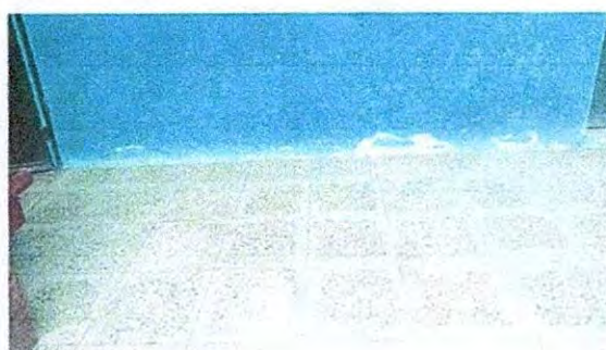
Foto 4: PISO 6.7 sustitución de piso de granito.
