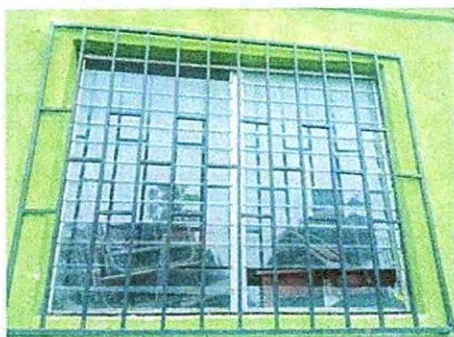
Foto 3: VENTANAS 5.1 mantenimiento estructura de metal de ventana.
