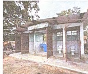
Foto 4: SUMINISTRO E INSTALACIÓN DE PUERTA, SUMINISTRO E INSTALACIÓN DE INODORO, SUMINISTRO E INSTALACIÓN DE AZULEJO, SUMINISTRO E INSTALACIÓN DE LAMINA, MANTENIMIENTO A ESTRUCTURA PORTANTE
