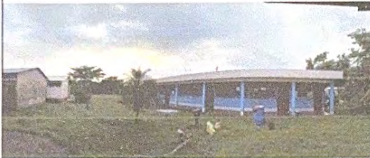
Foto 1: VISTA PANORAMICA DEL ESTABLECIMIENTO, AULAS CON FUNDICIÓN DE LOSA SE LES APLICÓ IMPERMEABILIZANTE
