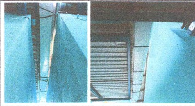
Foto 6: 7. CANALES Y BAJADAS DE AGUA. 7.1 Sustitución de canal de metal, 7.2 Sustitución de canal de pvc, 7.5 Sustitución de soporte o pescante de metal para canal.
