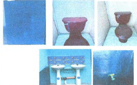
Foto 8: 10. SERVICIOS SANITARIOS Y ACCESORIOS. 10.1 Mantenimiento a estructura (fijado, cambio de tubo, cepillado, sujeciones, aplicación de pintura) a puertas servicios sanitarios, 10.2 Sustitución accesorio de inodora (contra llave, tubo de abasto y tanque), 10.4 Sustitución de mezcladora lavamanos (contra llave, tubo de abasto), 10.6 Sustitución de llave en migratorio, 10.11 Sustitución de tapadera sanitario
