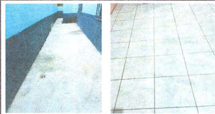
Foto 5: 6. PISO. 6.5 Sustitución de piso de torta de concreto, 6.8 Sustitución de piso de ceramico.
