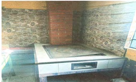
Foto13: 20. REPARACIÓN DE COCINA. 20.3 Sustitución de plancha de metal de 3 hornillas, 20.7 Instalación de azulejo en estufa rural.
