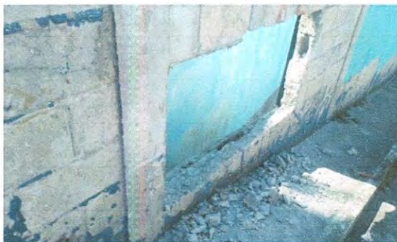
Foto 9: 15. MUROS PERIMETRALES. 15.1 Reparación muro perimetral de block.
