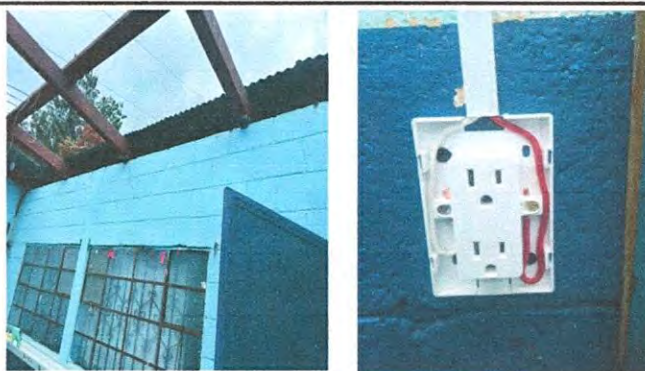
Foto 10: 17. REPARACIÓN DE SISTEMA ELECTRICO. 17.6 Sustitución de interruptores simples, 17.8 Sustitución de tomacorrientes dobles, 17.11 Reparación de cableado eléctrico, 17.12 Sustitución de ducto eléctrico+accesorios
