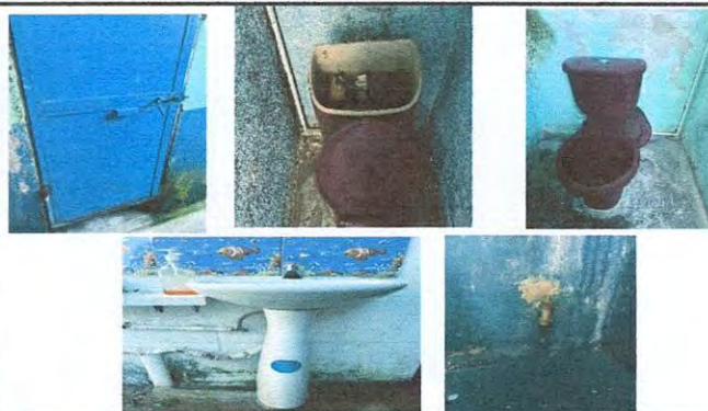
Foto 8: 10. SERVICIOS SANITARIOS Y ACCESORIOS. 10.1 Mantenimiento a estructura (lijado, cambio de tubo, cepillado, sujeciones, aplicación de pintura) a puertas servicios sanitarios, 10.2 Sustitución accesorio de inodora (contra llave, tubo de abasto y tanque), 10.4 Sustitución de mezcladora lavamanos (contra llave, tubo de abasto), 10.6 Sustitución de llave en migratorio, 10.11 Sustitución de tapadera sanitario
