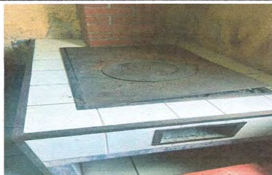
Foto13: 20. REPARACIÓN DE COCINA. 20.3 Sustitución de plancha de metal de 3 hornillas, 20.7 Instalación de azulejo en estufa rural.
