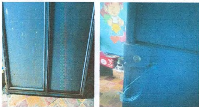
Foto 3: 4. Puertas de metal. 4.1 Mantenimiento a estructura (lijado, cambio de tubo, cepillado, sujeciones, aplicación de pintura, 4.2 Sustitución de chapa.
