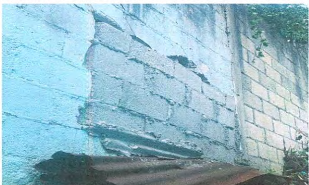
Foto 9: 15. MUROS PERIMETRALES. 15.1 Reparación muro perimetral de block.
