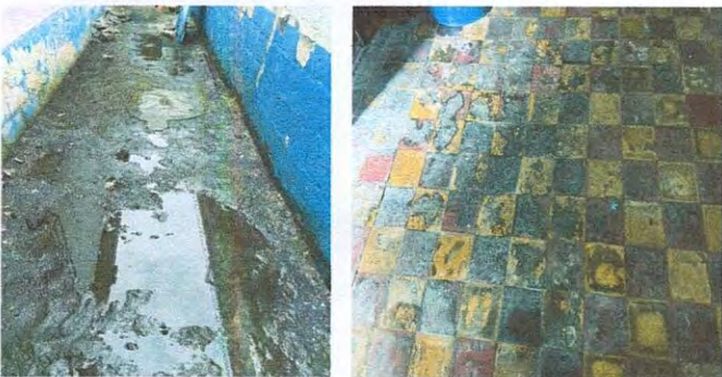
Foto 5: 6. PISO. 6.5 Sustitución de piso de torota de concreto, 6.8 Sustitución de piso de ceramico.
