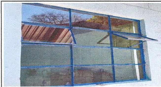
Foto 3: VENTANAS 5.5 Sustitución de vidrios.
