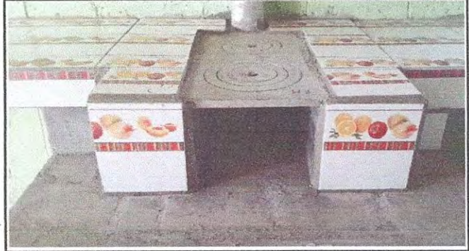
Foto 8: REPARACIÓN DE COCINA 20.2 Sustitución de estufa rural (completa) incluye chimenea y plancha de metal. 20.7 Instalación de azulejo en estufa rural.
