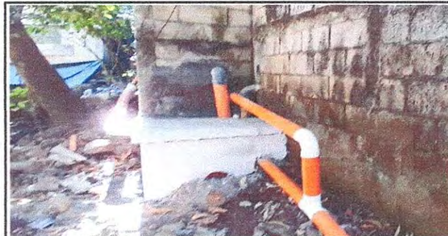
Foto 6: REPARACIÓN DE RED DE DRENAJE Y RED DE AGUA POTABLE. 14.3 Sustitución de tubería PVC línea principal de aguas negras. 14.8 Sustitución de caja de registro.
