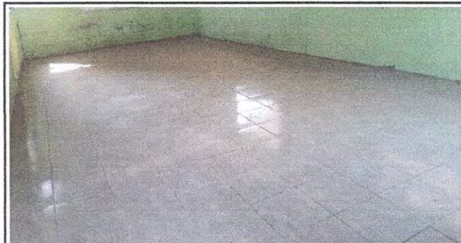
Foto 5: PISO 6.8 Sustitución de piso cerámico
