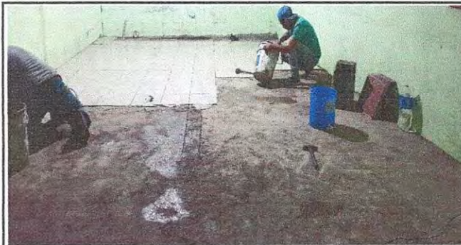
Foto 5: PISO 6.8 Sustitución de piso cerámico
