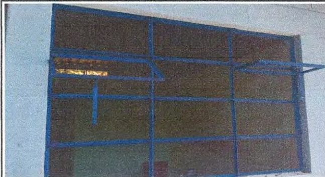
Foto 3: VENTANAS 5.5 Sustitución de vidrios.
