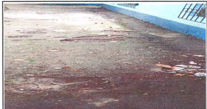
Foto 4: PISO 6.5 Sustitución de piso de torta de concreto
