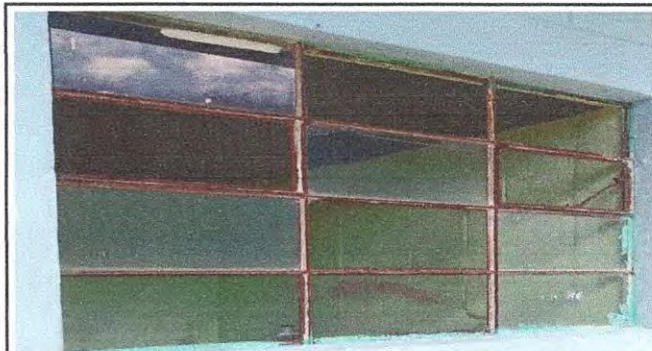
Foto 3: VENTANAS 5.5 Sustitución de vidrios.
