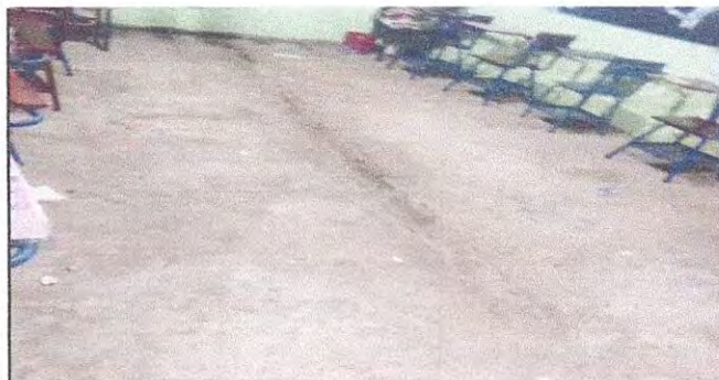
Foto 5: PISO 6.8 Sustitución de piso cerámico
