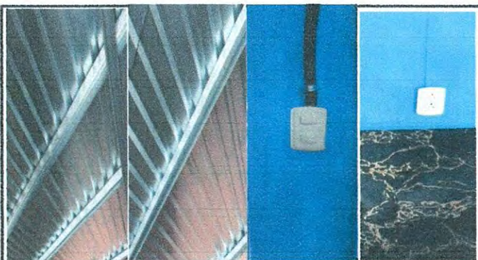
Foto 3: 19 MANO DE OBRA ESPECIALIZADA (ALBAÑILERÍA, HERRERÍA, ELECTRICIDAD Y PLOMERÍA) 19.9 desinstalación de estructura portante. 19.10 Desinstalación de lámina existente. 19.11 Instalación de unidades de luz. 19.12 Instalación de unidades de fuerza (tomacorrientes)
