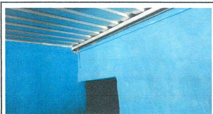
Foto 6: 21 REPARACION DE REPELLO Y CERNIDO EN PAREDES. 2.1 Repello en muro 21.2 Cernido en muro.
