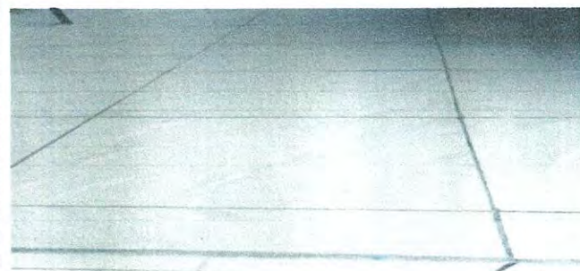
Foto 4: 6. PISO. 6.5 Sustitución de torta de concreto
