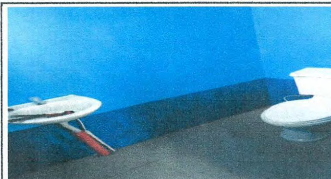
Foto 6: 10. SERVICIOS SANITARIOS Y SUS ACCESORIOS. 10.3 Sustitución de inodoro. 10.5 Sustitución de lavamanos.
