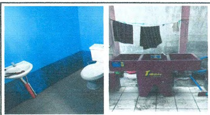
Foto 4: 19 MANO DE OBRA ESPECIALIZADA (ALBAÑILERÍA, HERRERÍA, ELECTRICIDAD Y PLOMERÍA) 19.15 Instalación de inodoro. 19.17 Instalación de lavamanos. 19.20 Instalación de pila.
