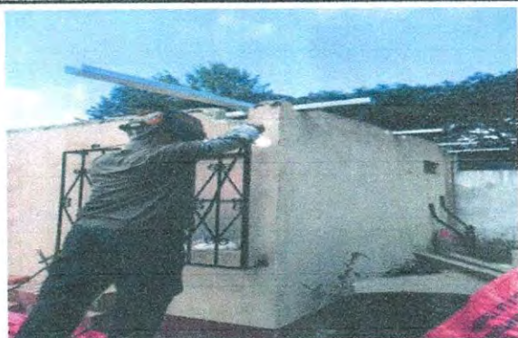
Foto 3: 5 VENTANAS 5.7 Mantenimiento a balcones de metal
