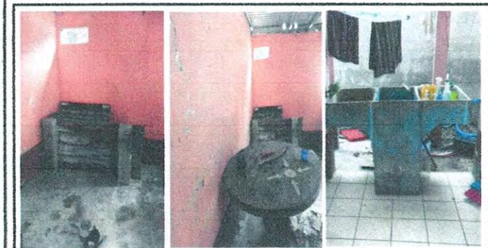
Foto 5: 20 REPARACIÓN DE COCINA 20.2 Sustitución de estufa rural (completa) incluye chimenea y plancha de metal. 20.7 instalación de azulejo en estufa rural. 20.12 Sustitución de pila plástica de dos lavaderos.
