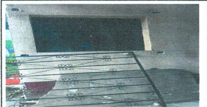
Foto 3: 5 VENTANAS 5.7 Mantenimiento a balcones de metal
