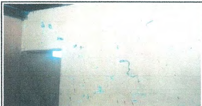
Foto 6: 21 REPARACIÓN DE REPELO Y CERNIDO DE PAREDES. 21.1 Repello en muro. 21.2 Cernido en muro.
