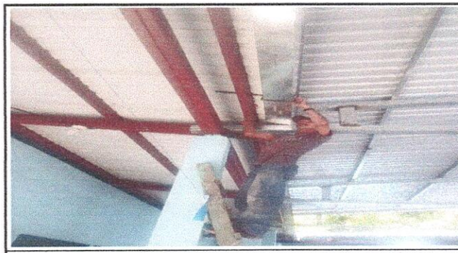
Foto 6: CANALES Y BAJADAS DE AGUA PLUVIAL 7.5 Sustitución de soporte o pescante de metal para canal.
