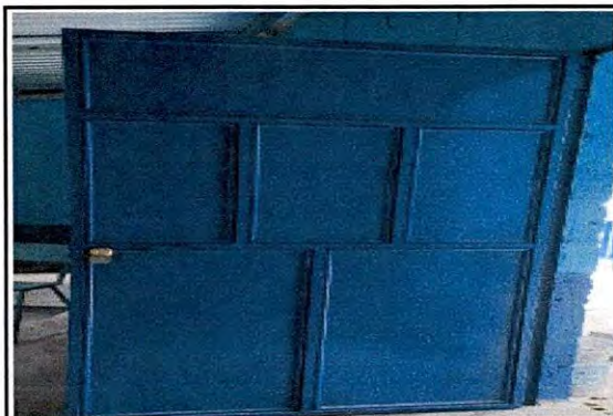
Foto 3: PUERTAS DE METAL 4.1 Mantenimiento a estructura (lijado, cambio de tubo, cepillado, sujeciones, aplicación de pintura) 4.2 Sustitución de chapa 4.3 Sustitución de Puerta.
