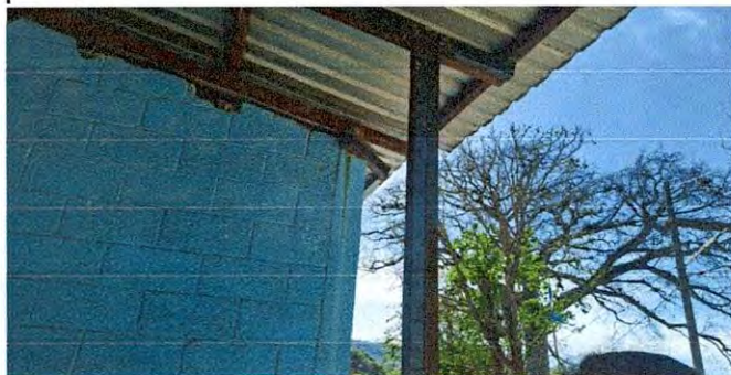
Foto 2: ESTRUCTURA DE TECHO 2.1 Mantenimiento a estructura de soporte de metal
