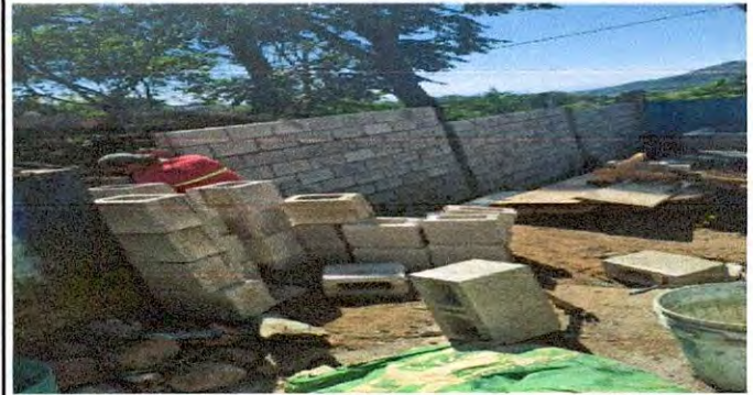
Foto 2: MUROS PERIMETRALES 15.1 Sustitución de muro prefabricado por muro de block
