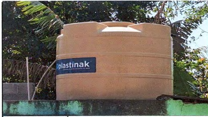
Foto 10: 18 REPARACIÓN Y MANTENIMIENTO DE CISTERNAS/DEPOSITOS DE AGUA: 18.3 Sustitución de deposito de agua 1700 litros.
