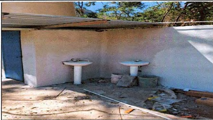
Foto 7: 10 SERVICIOS SANITARIOS Y SUS ACCESORIOS. 10.5 Sustitución de lavamanos.
