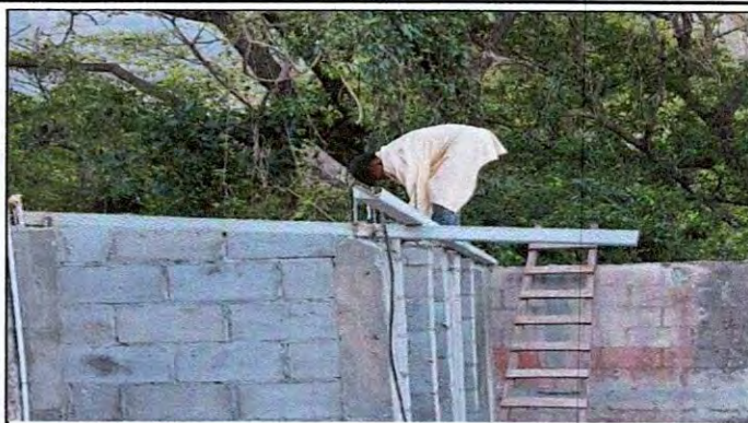
Foto 2: 1 CUBIERTA DE LÁMINA: 1.3 Sustitución de elementos de fijación.
