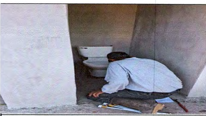
Foto 6: 10 Servicios sanitarios y sus accesorios: 10.3 Sustitución de inodoros
