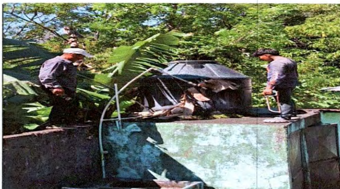
Foto 10: 18 REPARACIÓN Y MANTENIMIENTO DE CISTERNAS/DEPOSITOS DE AGUA: 18.3 Sustitución de deposito de agua 1700 litros.
