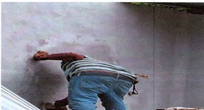
Foto 12: 21 Reparación de repello y cernido de paredes 21.2 cernido en muro.
