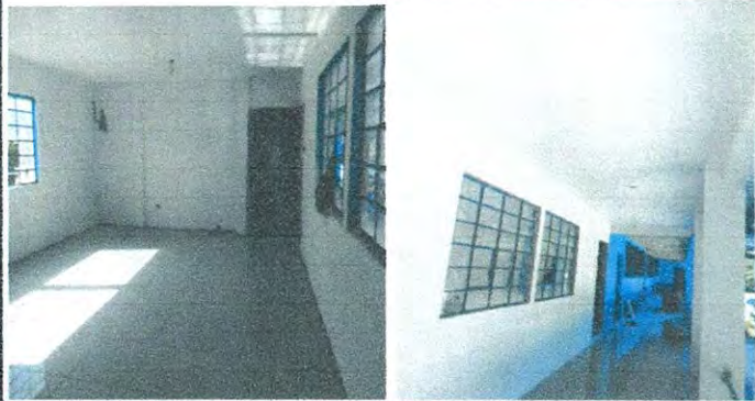
Foto1: LOSA DE AULA DE TERCERO PRIMARIA
