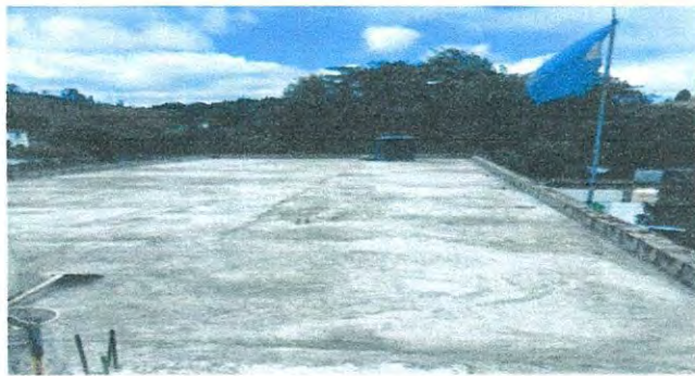
Foto 3: 3. IMPERMEABILIZACIÓN DE LOSA. 3.2 Reparación de pañuelos.
