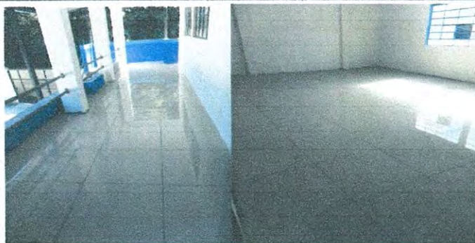
Foto 5: 6. PISO. 6.1 Sustitución de piso de torta de concreto.
