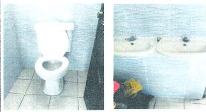
Foto 2: 13 SUSTITUCIÓN DE AZULEJO. 13.1 Sustitución de azulejo
