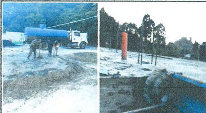
Foto1: LOSA DE AULA DE TERCERO PRIMARIA
