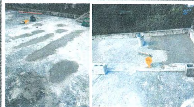
Foto 3: 3.IMPERMEABILIZACIÓN DE LOSA. 3.2 Reparación de pañuelos
