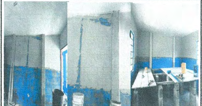
Foto 4: 21 REPARACIÓN DE REPELLO Y CERNIDO (CUANO APLIQUE) 21.1 Repello en muro. 21.2 Cernido en muro.
