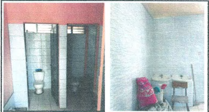
Foto 2: 13 SUSTITUCIÓN DE AZULEJO. 13.1 Sustitución de azulejo
