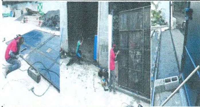
Foto 1: 12 MANTENIMIENTO A PORTONES. 12.1 Mantenimiento a portones de metal.
