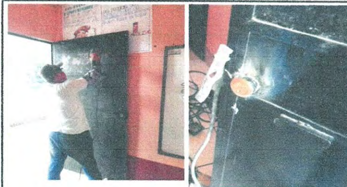
Foto 4: 4.PUERTAS DE METAL. 4.1 Mantenimiento a estructura (pintura) 4.2 Sustitución de chapa.
