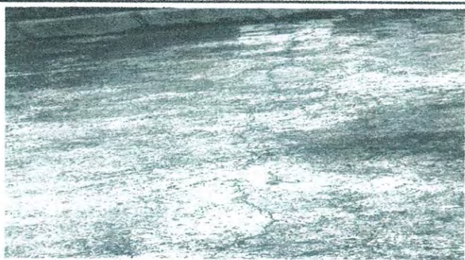
Foto 3: 3.IMPERMEABILIZACIÓN DE LOSA. 3.2 Reparación de pañuelos.
