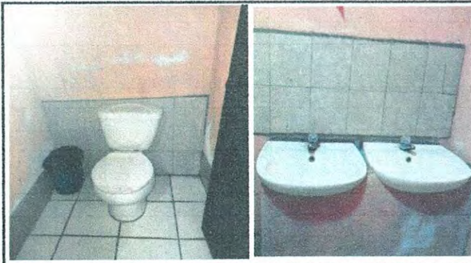
Foto 2: 13 SUSTITUCIÓN DE AZULEJO. 13.1 Sustitución de azulejo
