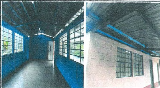
Foto1: LOSA DE AULA DE TERCERO PRIMARIA
