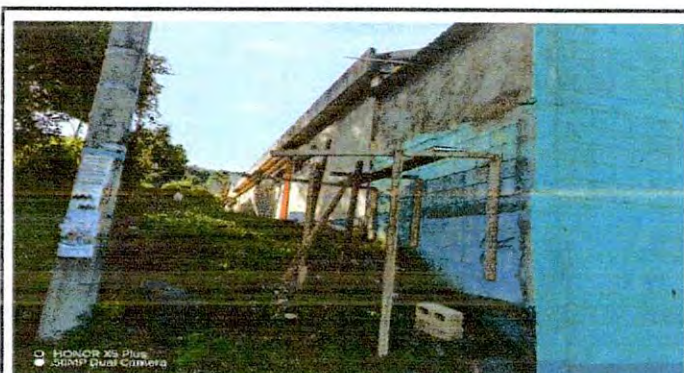
Foto 10: 21 REPARACION DE REPEO Y CERNIDO DE PAREDES 21.3 ALISADO EN MURO
