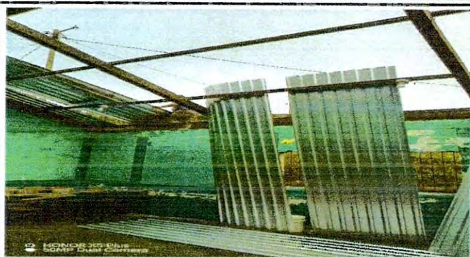
Foto 1: 1 CUBIERTA DE LAMINA 1.1 SUSTITUCION DE LAMINA, POR LAMINA RTOQUELADA CALIBRE 26 1.3 SUSTITUCION DE ELEMENTOS DE FIJACION
