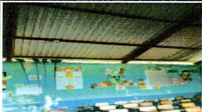
Foto 1: 1 CUBIERTA DE LAMINA 1.1 SUSTITUCION DE LAMINA, POR LAMINA TROQUELADAS CALIBRE 26 1.3 SUSTITUCION DE ELEMENTOS DE FIJACION
