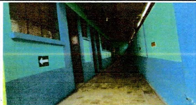
Foto 3: 6 PISO 6.7 SUSTITUCION DE PISO DE GRANITO
