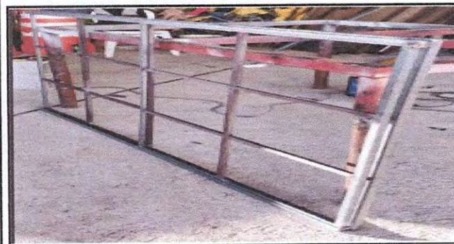
Foto 6: VENTANAS 5.2 Sustitución de estructura de metal de ventana 5.5 Sustitución de vidrios
