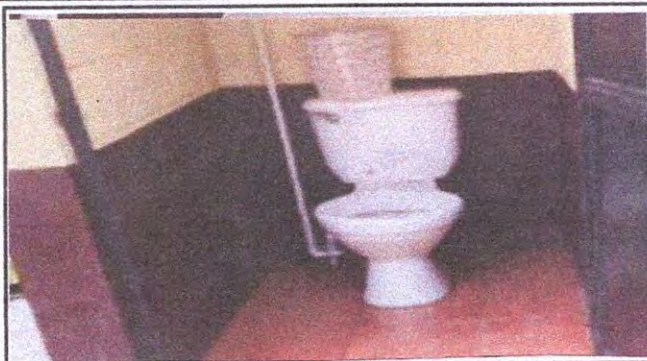
Foto 2: SERVICIOS SANITARIOS Y SUS ACCESORIOS 10.2 Sustitución de accesorios inodoro (contra llave, tubo de abasto y tanque) 10.10 Sustitución de llave de paso
