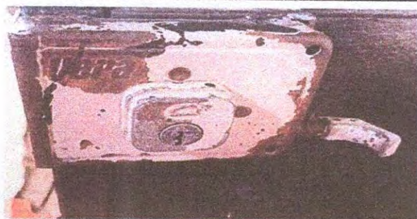
Foto 5: PUERTAS DE METAL 4.2 Sustrución de chapa 4.3 Sustrución de puerta
