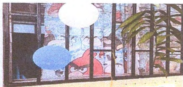
Foto 6: VENTANAS 5.2 Sustrución de estructura de metal de ventana 5.5 Sustrución de vidrios
