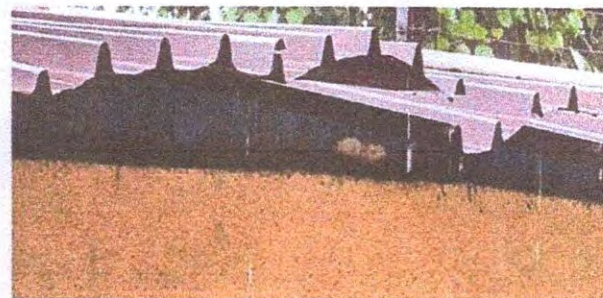
Foto 2: CUBIERTA DE LÁMINA. Sustrución de lámina, por lámina troquelada aluzinc calibre 26
