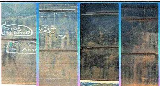
FOTO 3: 4. PUERTA DE METAL 4.1 Mantenimiento a estructura (lijado, cambio de tubo, cepillado, sujeciones, aplicación de pintura)
