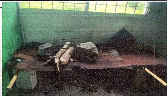
FOTO 11: 20 REPARACION DE COCINAS 20.2 Sustitución de estufa rural (completa) Incluye chimenea y plancha de metal
