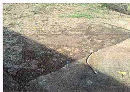
FOTO 10: 16 LOSA DE PATIO 16.1 Reparacion de planchas de concreto de patio
