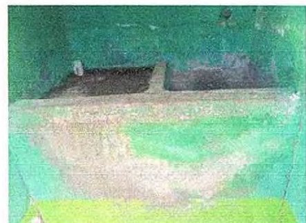
FOTO 12: 10.10 Sustitucion de pila de cemento de dos lavaderos
