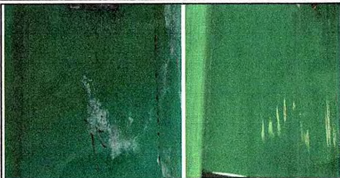
FOTO 13: 21 REPARACION DE REPELLO Y CERNIDO DE PAREDES ( CUANDO APLIQUE) 21.1 Repello de muro
