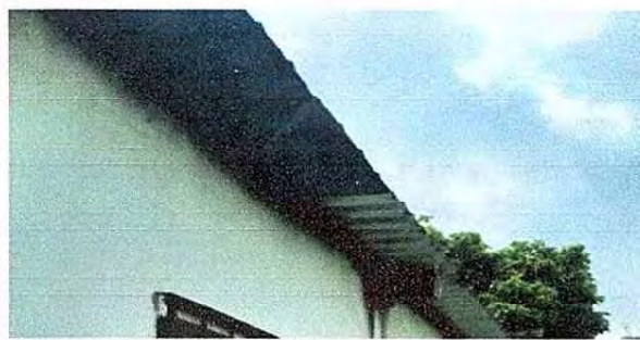
FOTO 6: 7 CANALES Y BAJADAS DE AGUA PLUVIAL 7.1 Sustitucion de canal de metal.
