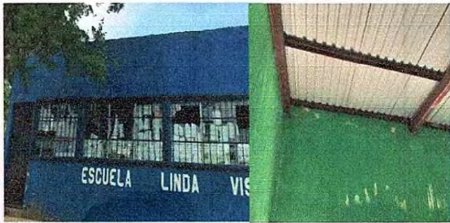
FOTO 7: 9 PINTURA EN MUROS EXTERIORES E INFERIORES
