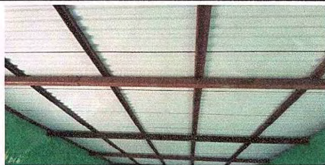
FOTO 2: 2 ESTRUCTURA DE TECHO 2.1 Mantenimiento de estructura y soporte de metal. 2.3 sustitucion de soporte de metal por metal.
