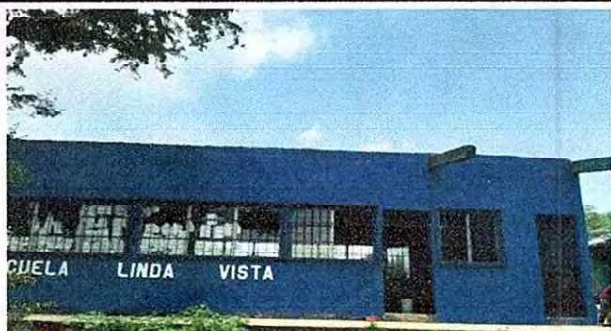
FOTO 1: 1 CUBIERTA DE LAMINA 1.1 Sustitucion de lamina por lamina troquelada aluzinc calibr4e 26. 1.3 sustitucion de elementos de fijacion
