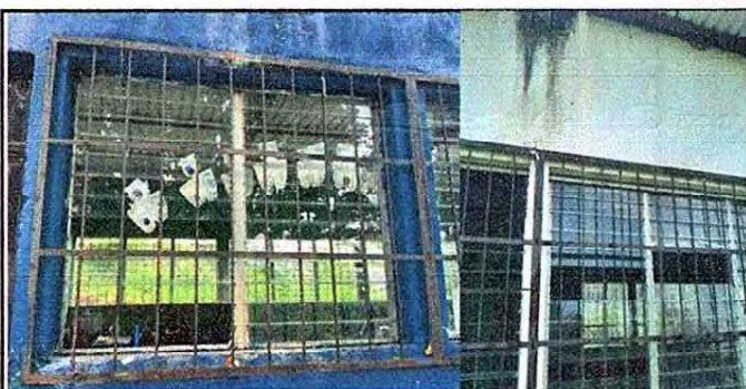
FOTO 5: 5 VENTANAS 5.4 Mantenimiento de marcos de aluminio mill finish. 5.5 sustitucion de vidrios 5.7 mantenimiento de balones de metal
