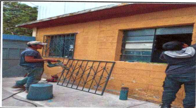
Foto 19: Instalación de Balcones de Metal
