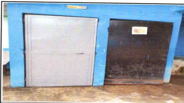
Foto 14: Inicio de matenimiento de puertas de sanitarios
