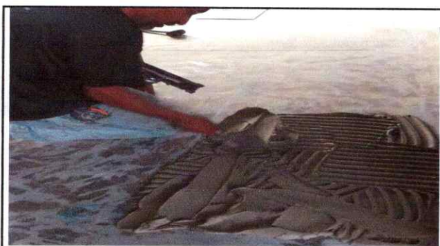
Foto 3: Início de Instalação de piso cerâmico
