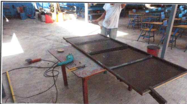
Foto 16: Inicio de matenimiento de puertas de sanitarios
