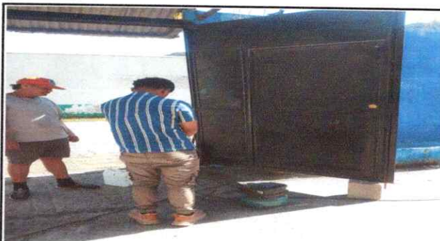
Foto 22: Inicio de mantenimiento de Porton de metal
