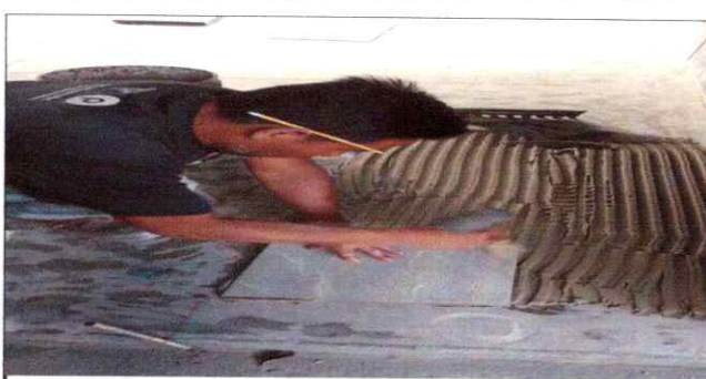
Foto 4: Início de Instalação de piso cerâmico
