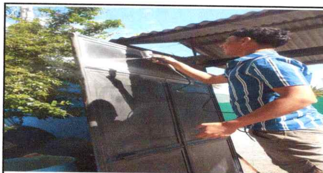
Foto 24: Inicio de mantenimiento de Porton de metal
