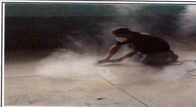
Foto 2: Início de Instalação de piso cerâmico
