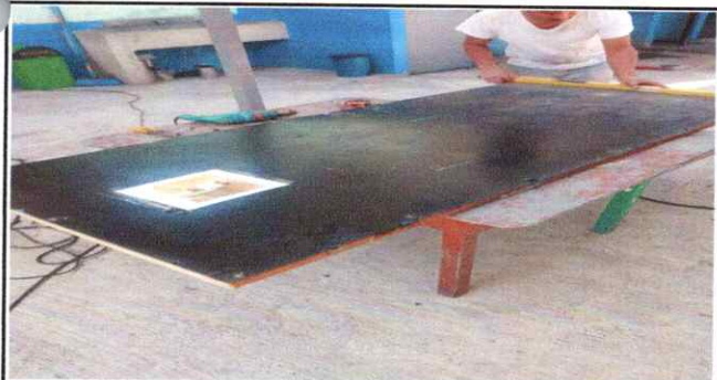
Foto 17: Inicio de matenimiento de puertas de sanitarios
