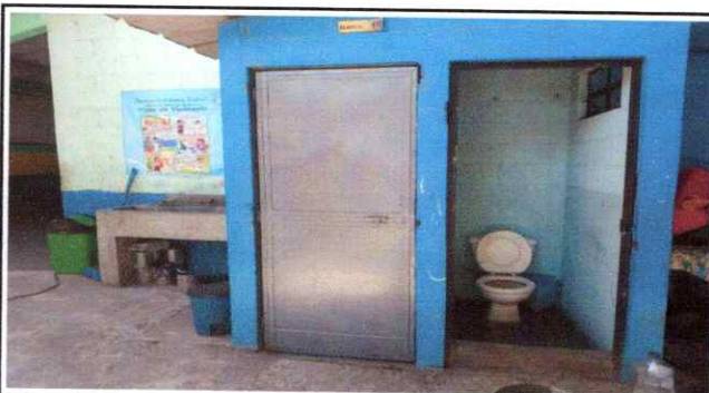
Foto 18: Inicio de matenimiento de puertas de sanitarios
