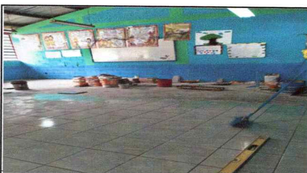
Foto 6: Início de Instalação de piso cerâmico
