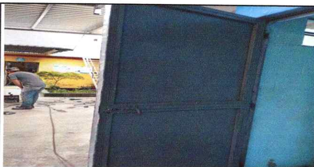
Foto 15: Inicio de matenimiento de puertas de sanitarios
