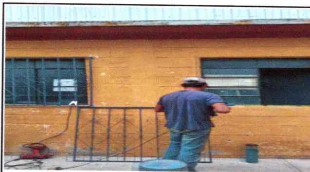
Foto 20: Instalación de Balcones de Metal
