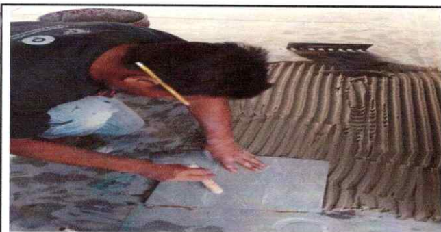
Foto 5: Início de Instalação de piso cerâmico
