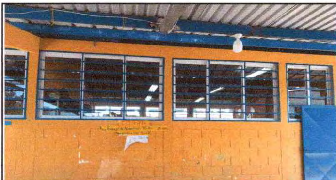
Foto 3: Instalación de energía eléctrica, área del corredor
