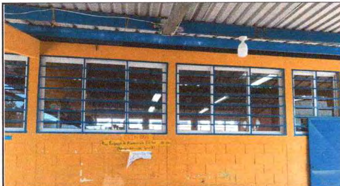
Foto 3: Instalación de Ventanas de PVC
