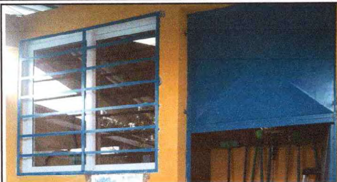
Foto 1: Mantenimiento de estructura de metal de ventana
