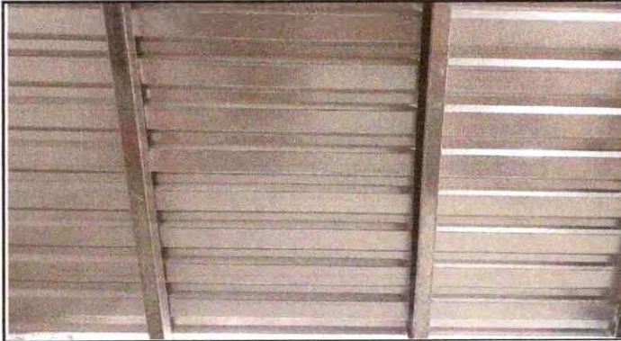
Foto 1: Instalación de lámina troquelada , área interior de la cocina
