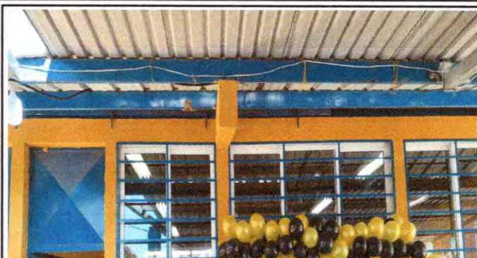
Foto 2: Instalación de energía eléctrica, área del corredor
