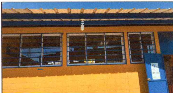
Foto 4: Mantenimiento a estructura de metal de ventana
