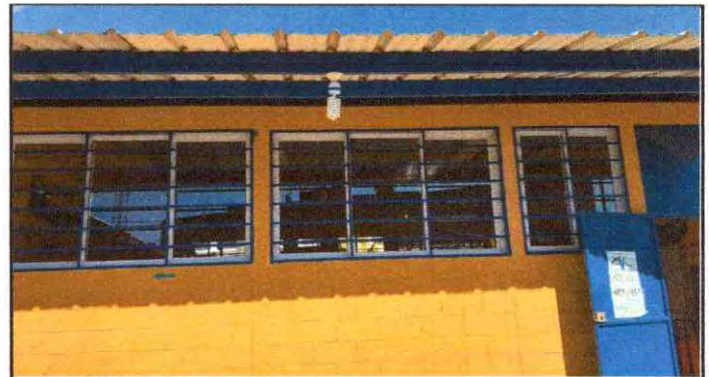
Foto 4: Instalación de ventanas de PVC
