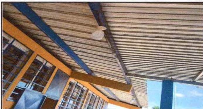
Foto1: Instalación de energía eléctrica, área del corredor
