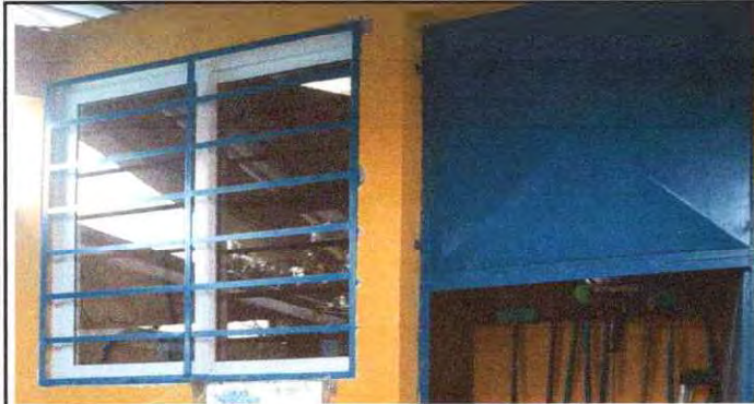
Foto1: Instalación de ventana de PVC
