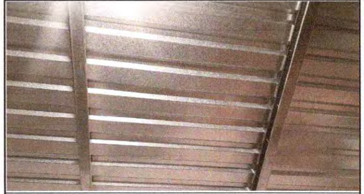
Foto 2: Instalación de lámina troquelada, área interior de la cocina.
