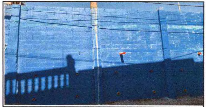
Foto 6: reparación de muro perimetral de block y muro de contención
