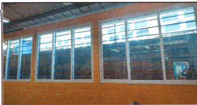
Foto 5: Instalacion de ventanas de PVC
