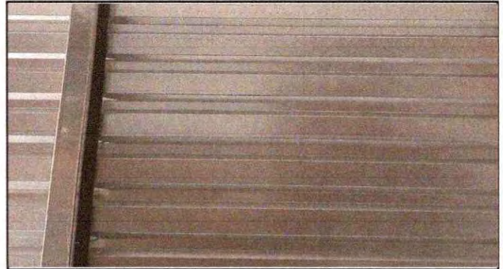
Foto 4: Instalación de lámina troquelada , área exterior de cocina
