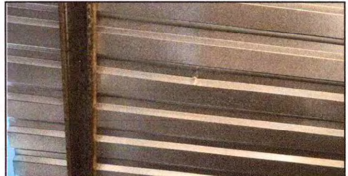
Foto 6: Instalación de lámina troquelada, área exterior de la cocina
