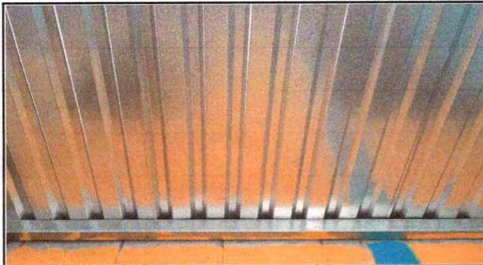
Foto 3: Instalación de lámina troquelada, área exterior de la cocina
