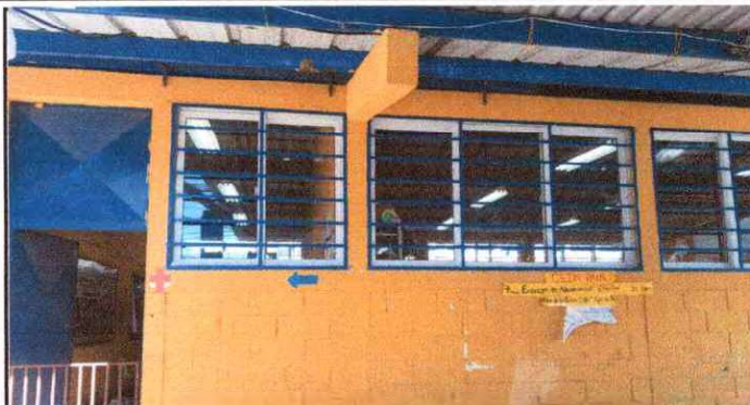
Foto 2: Mantenimiento a estructura de metal de ventana
