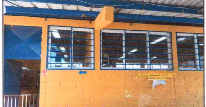
Foto 2: Instalación de ventanas de PVC
