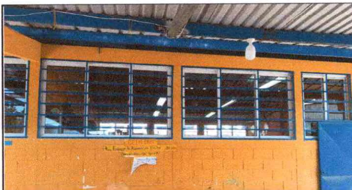
Foto 3: Mantenimiento a estructura de metal de ventana
