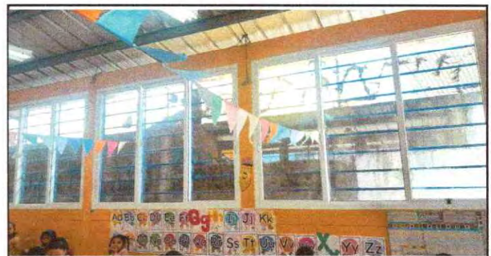
Foto 6: Instalación de ventanas de PVC
