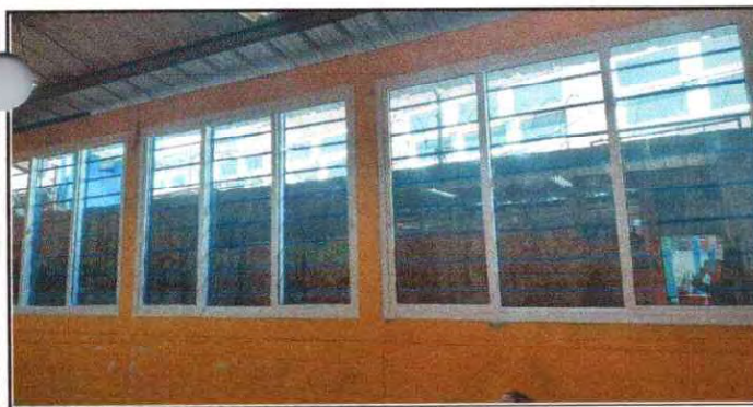
Foto 5: Mantenimiento a estructura de metal
