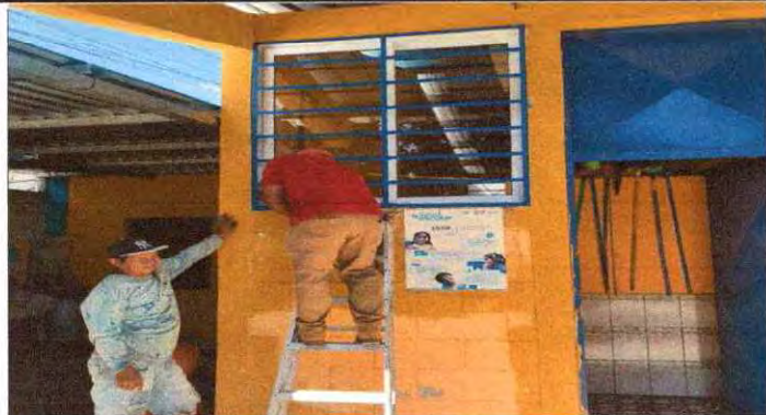
Foto 1: Mantenimiento a estructura de metal de ventana
