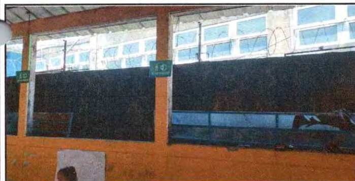
Foto 5: Mantenimiento a estructura de metal de ventana
