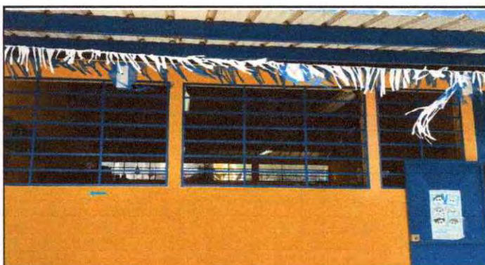
Foto 4: Mantenimiento a estructura de metal de ventana
