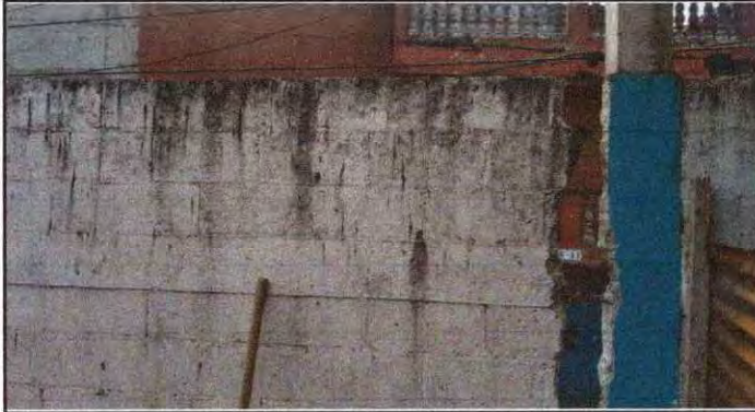
Foto 1: Muro perimetral de block, área interior
