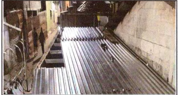
Foto 2: Instalación de lámina troquelada, área interior de cocina.
