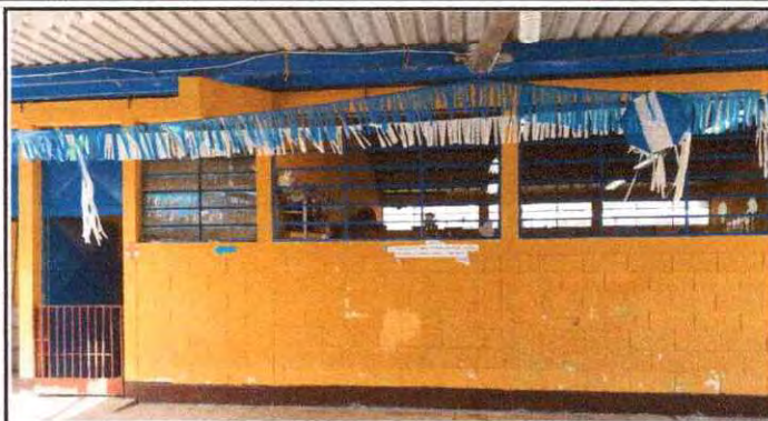
Foto 2: Mantenimiento a estructura de metal de ventana
