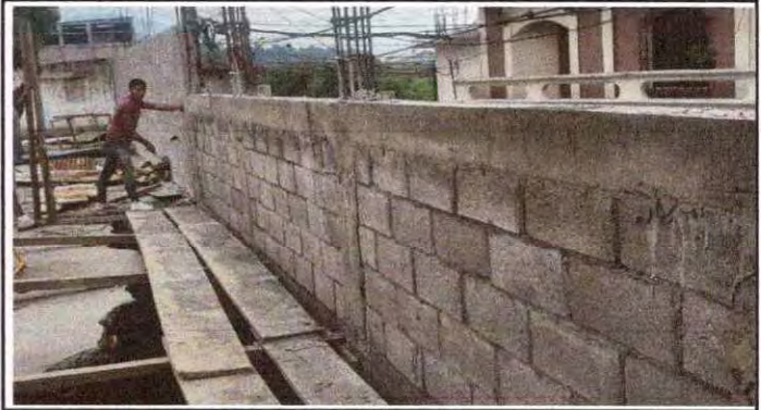
Foto 2: Muro perimetral de block, área interior.
