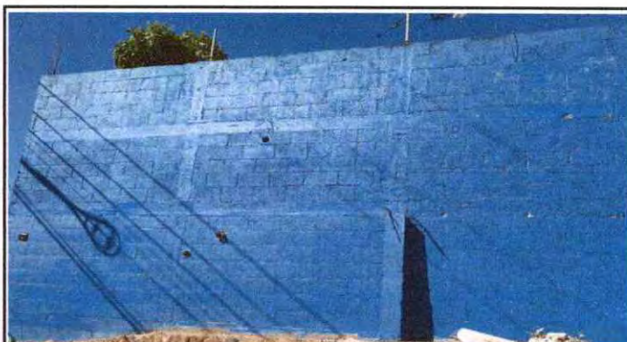
Foto 4: Pintura en muro perimetral, area exterior
