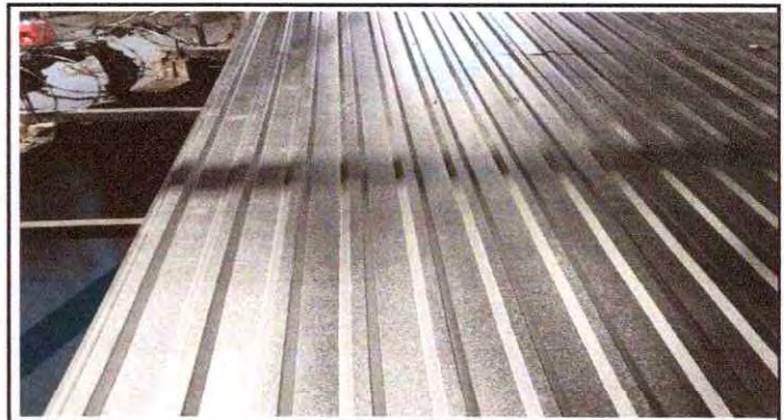
Foto 4: Instalación de lámina troquelada , área exterior de cocina
