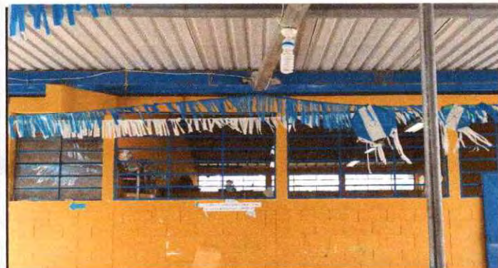
Foto 3: Mantenimiento a estructura de metal de ventana
