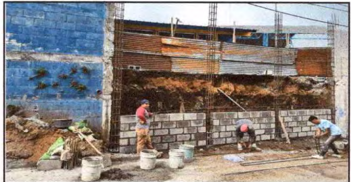
Foto 6: Muro perimetral de block y de contención, área exterior
