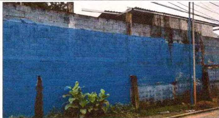
Foto 1: Pintura en muro perimetral, area exterior
