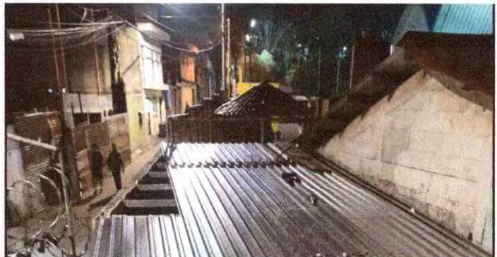
Foto 6: Instalación de lámina troquelada, área interior de cocina
