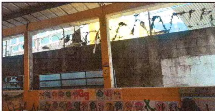
Foto 6: Mantenimiento a estructura de metal de ventana
