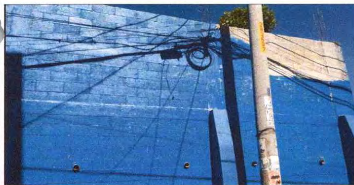
Foto 5: Pintura en muro perimetral, area exterior
