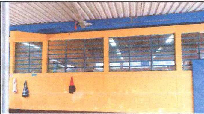
FOTO 3: Instalación de energía eléctrica en el corredor.
