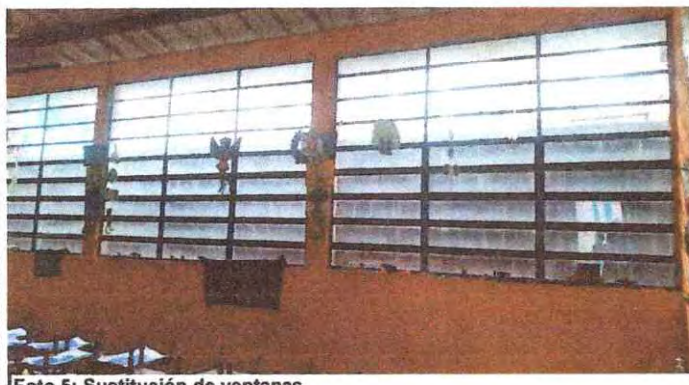
Foto 5: Sustrución de ventanas
