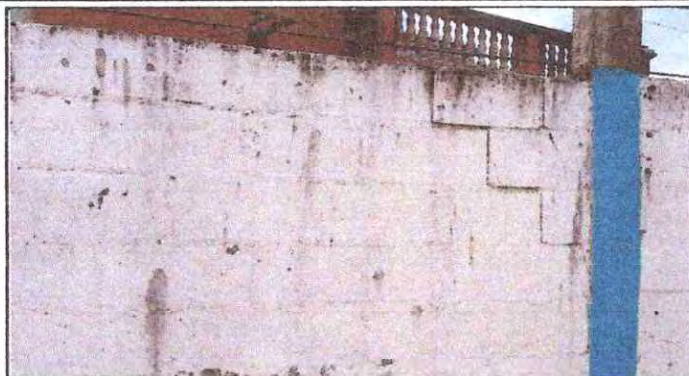
FOTO 1: Reparación de muro perimetral de block
