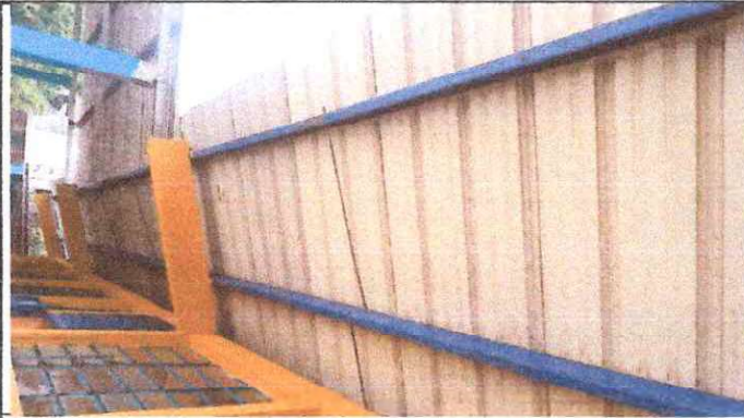
FOTO 1: Instalación de energía eléctrica en el corredor.
