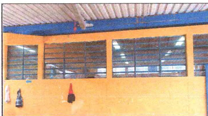
Foto 3: Sustrución de ventanas
