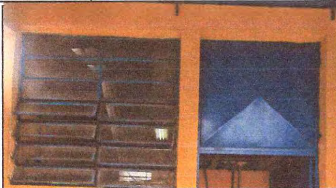
FOTO 1: Sustrución de ventanas
