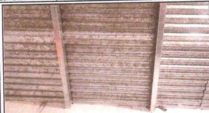
Foto 1. Desinstalación y Sustitución de lámina por troquelada
