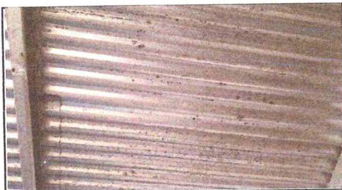
Foto 4: Desinstalación y Sustitución de lámina por troquelada
