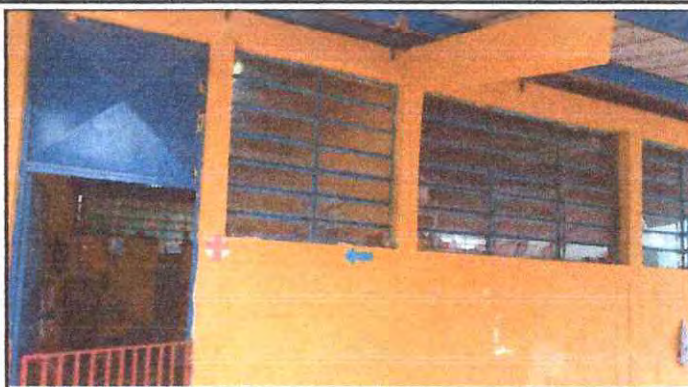
Foto 2: Sustrución de ventanas
