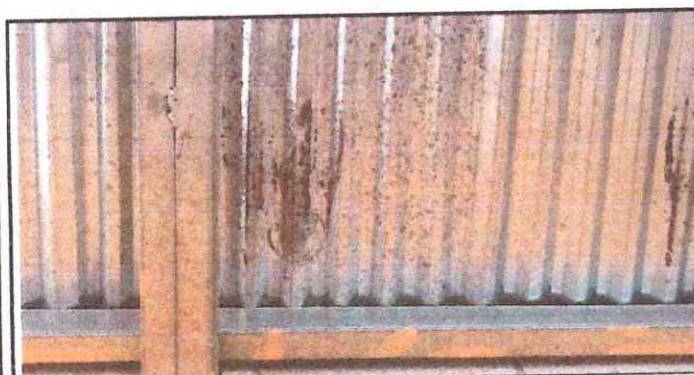
Foto 5: Desinstalación y Sustitución de lámina por troquelada
