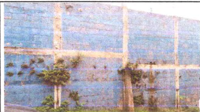
Foto 2: Pintura en muro perimetral
