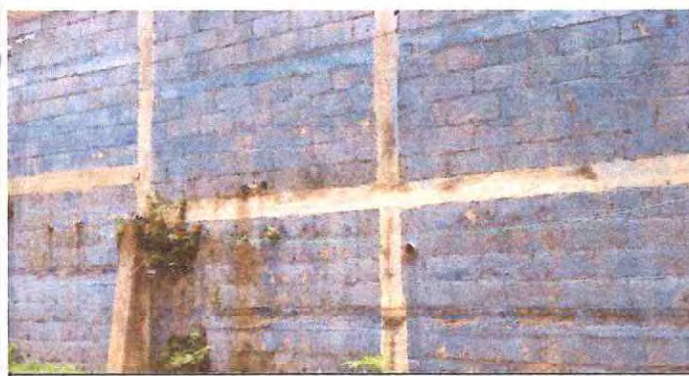
Foto 5: Reparación de muro perimetral de block y de contención
