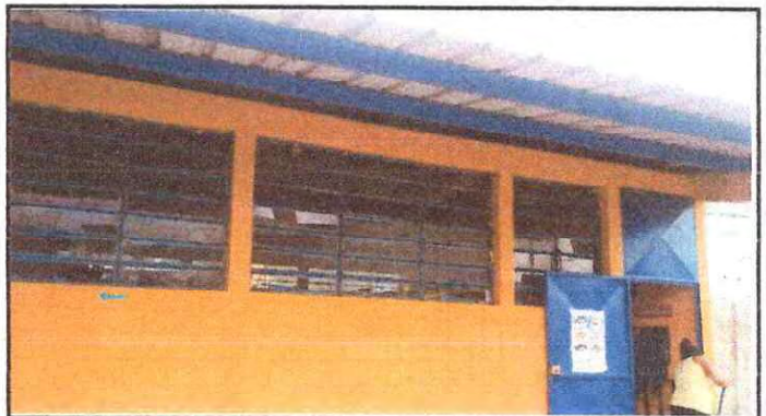
FOTO 4: Instalación de energía eléctrica en el corredor
