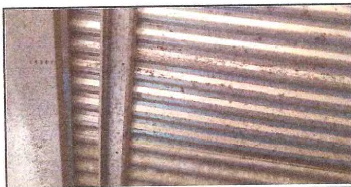
Foto 6: desinstalación y Sustitución de lámina por troquelada
