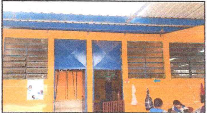
Foto 2: Instalación de energía eléctrica en el corredor
