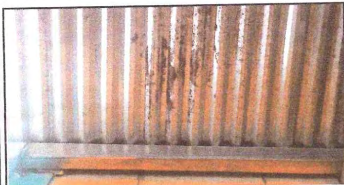
Foto 3: Desinstalación y Sustitución de lámina por troquelada
