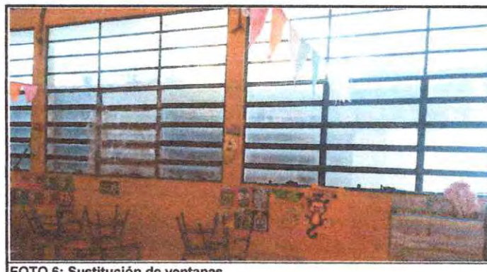
FOTO 6: Sustrución de ventanas
