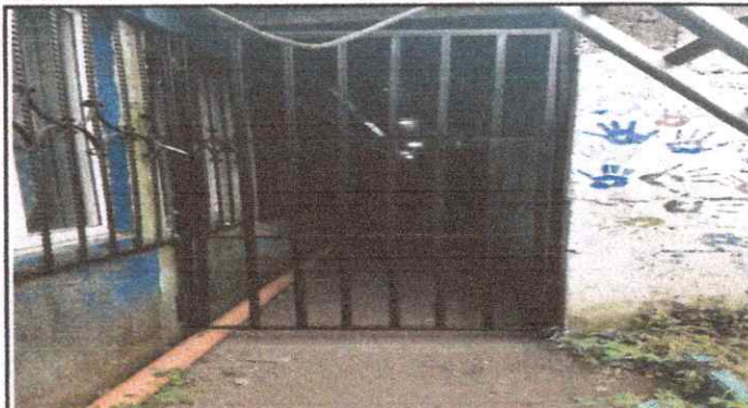
Foto 2: Fabricación e instalación de puerta de rejas
