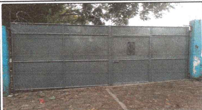
Foto 1: Mantenimiento a portones de metal
