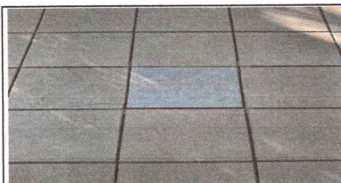
Foto 5: Sustitución de Piso Cerámico
