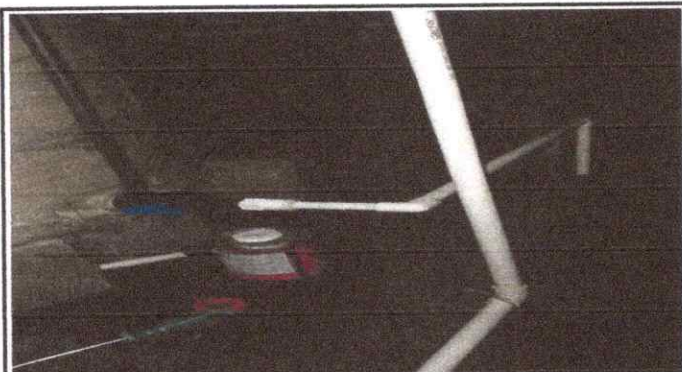
Foto 3: Instalación de tubería para agua potable
