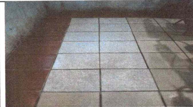
Foto 4: Sustitución de Piso Cerámico
