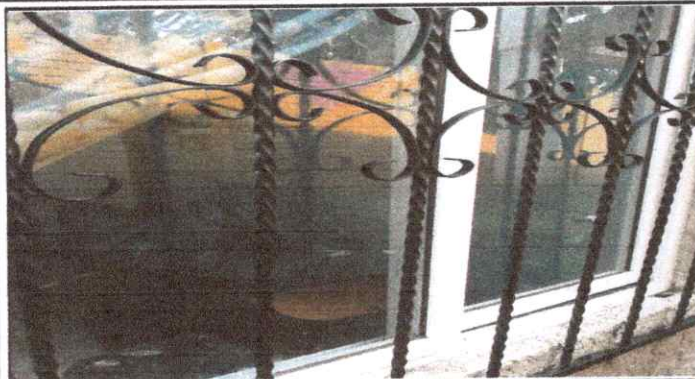
Foto 1: Mantenimiento a balcones de metal.
