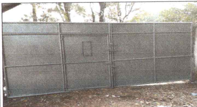
Foto 3: Mantenimiento a portones de metal
