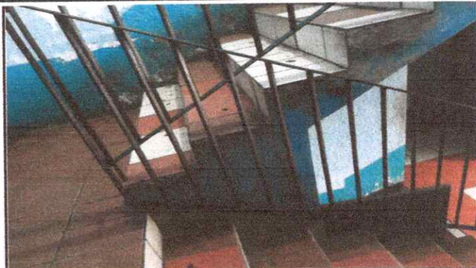
Foto 2: Mantenimiento a barandas de metal
