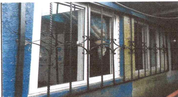
Foto 3: Mantenimiento a balcones de metal.
