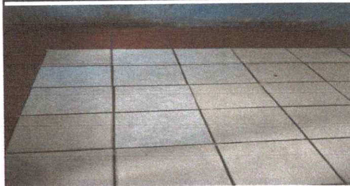
Foto 2: Sustitución de Piso Cerámico
