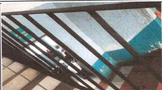
Foto 1: Mantenimiento a barandas de metal
