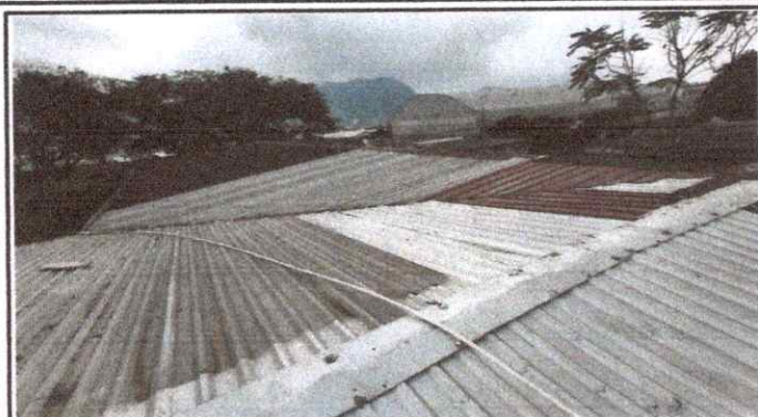
Foto 1: Sustitución de canal de metal
