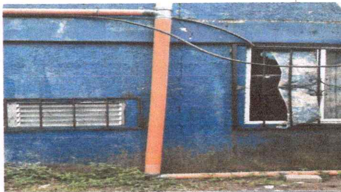
Foto 4: Reparación de baja de agua pluvial tubo PVC 3"
