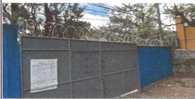
Foto 2: Reparación de cerco de alambre de pua.
