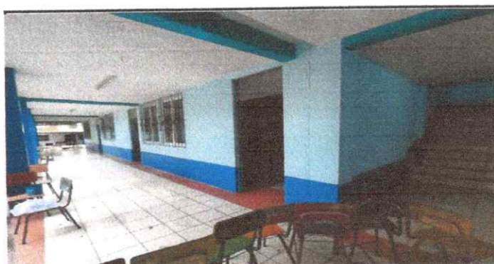
Foto 12: finalización de pintura de exteriores e interiores
