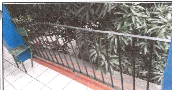
Foto 6: Mantenimiento a barandas de metal
