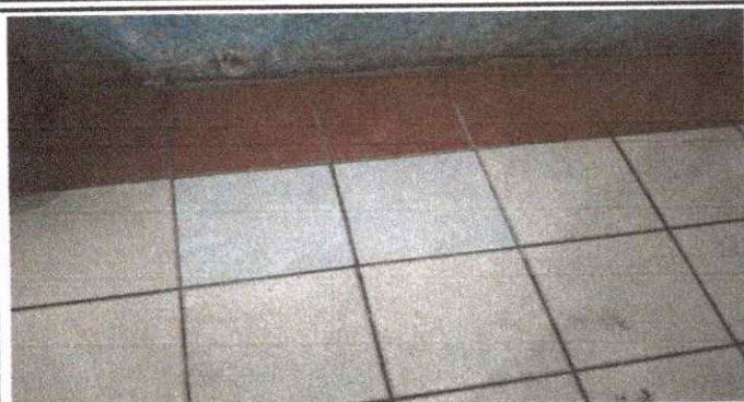
Foto 1: Sustitución de Piso Cerámico
