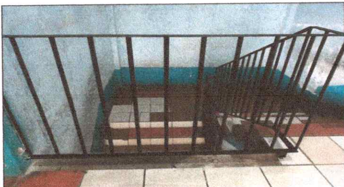
Foto 4: Mantenimiento a barandas de metal
