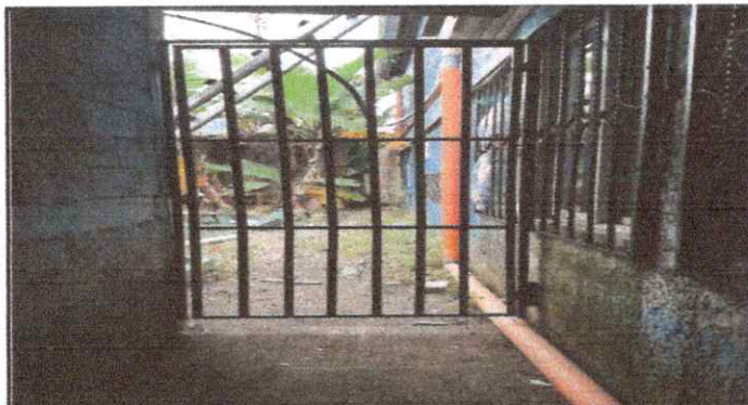
Foto 3: Fabricación e instalación de puerta de rejas
