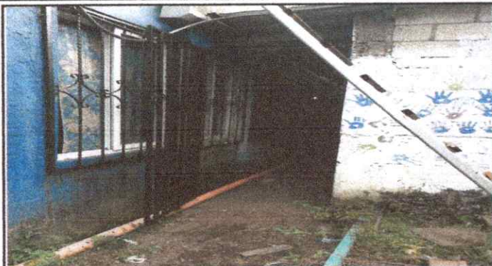
Foto 1: Fabricación e instalación de puerta de rejas
