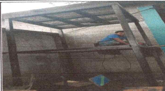
Foto 2: Instalación de estructura portante de metal
