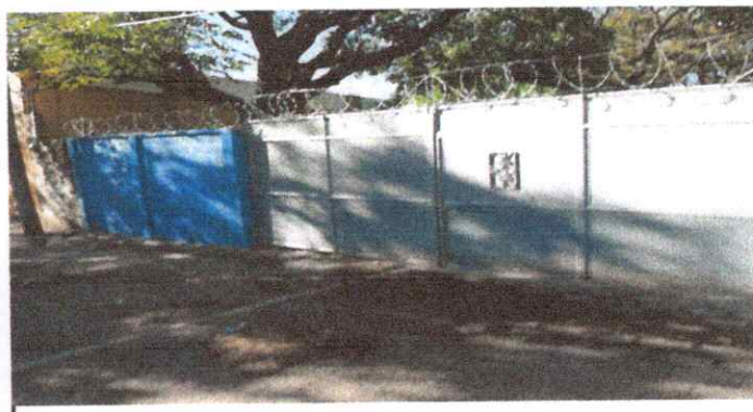
Foto 4: Mantenimiento a portones de metal
