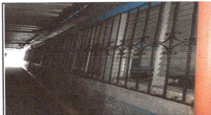
Foto 4: Mantenimiento a balcones de metal
