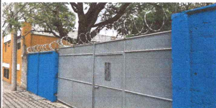
Foto 1: Reparación de cerco de alambre de pua.
