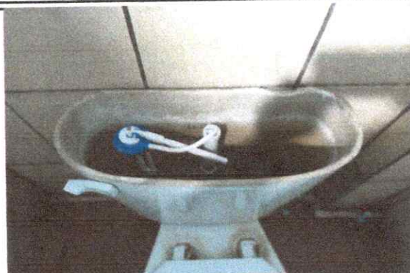
Foto 2: Sustrucción de accesorios inodoro (contra llave, tubo de abasto y tanque)
