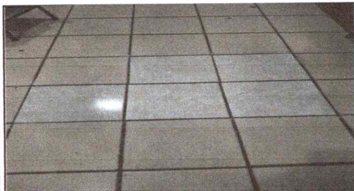
Foto 3: Sustitución de Piso Cerámico
