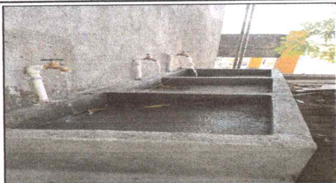
Foto 1: Instalación de tubería para agua potable
