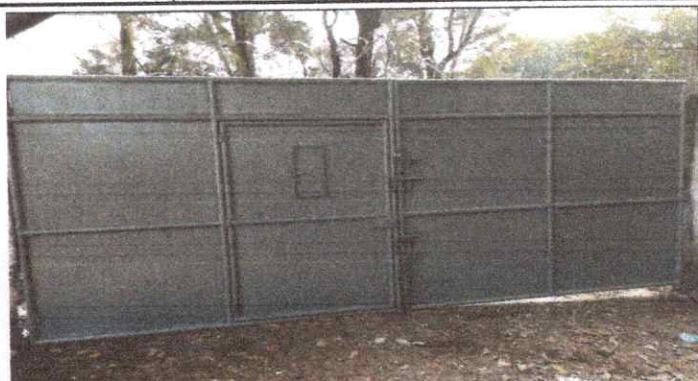
Foto 2: Mantenimiento a portones de metal
