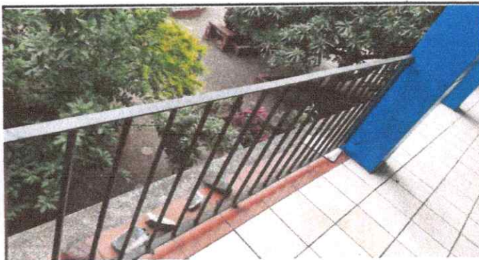
Foto 5: Mantenimiento a barandas de metal
