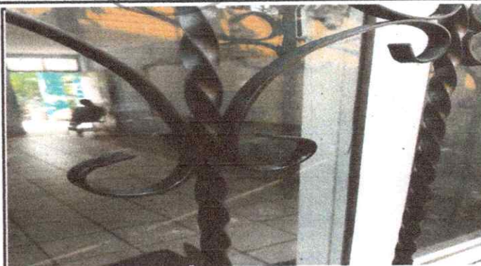
Foto 2: Mantenimiento a balcones de metal.
