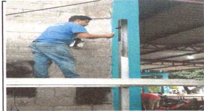
Foto 4: Instalación de estructura portante de metal
