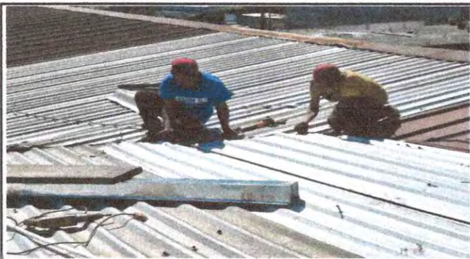
Foto1: Sustitución de canal de metal.
