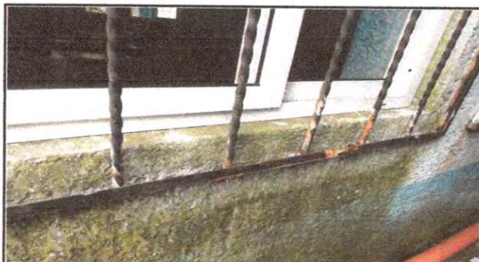
Foto 3: Mantenimiento a balcones de metal.
