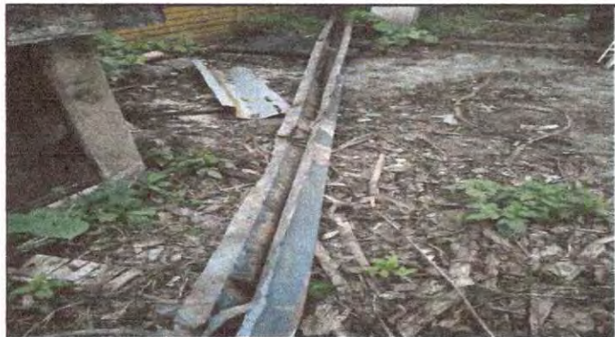
Foto 3: Sustitución de canal de metal.
