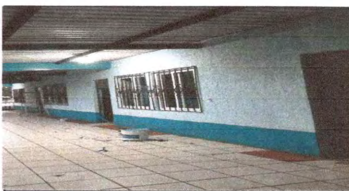
Foto 6: pintura de exteriores e interiores
