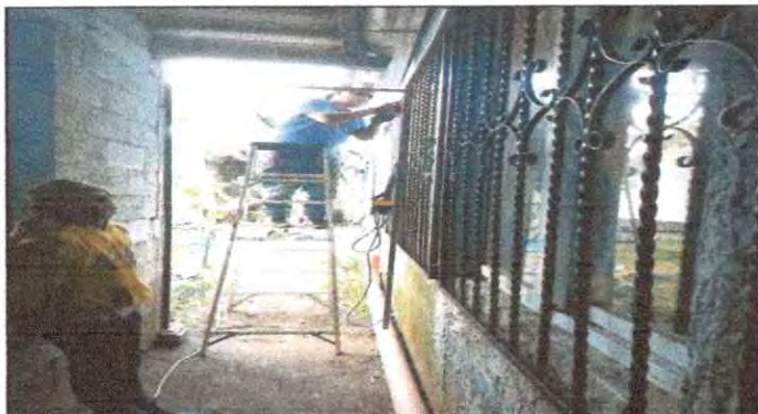
Foto 3: Fabricación e instalación de puerta de rejas
