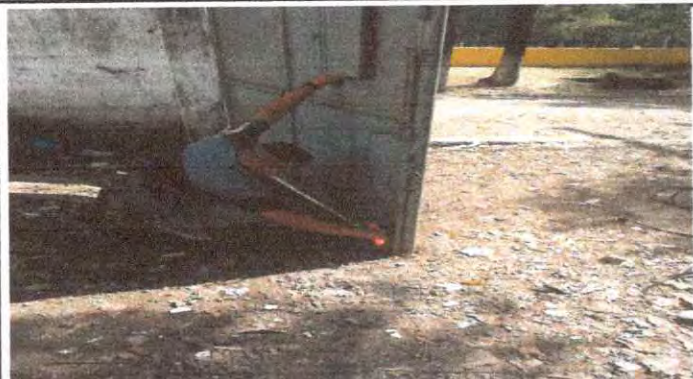
Foto 1: Mantenimiento a portones de metal
