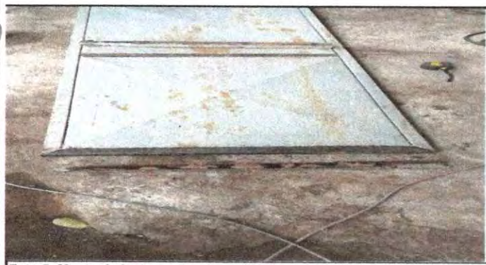
Foto 5: Mantenimiento a estructura, (lijado, cambio de tubo, cepillado, sujeciones, aplicación de pintura)
