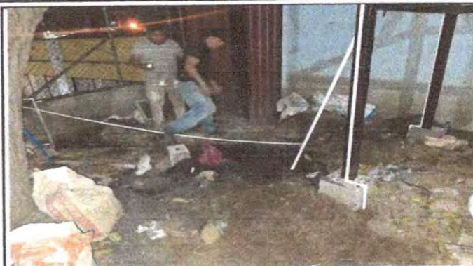
Foto 2: Instalación de tubería para agua potable
