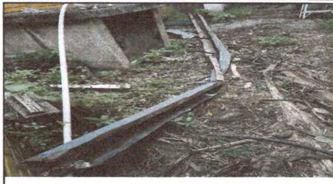
Foto 2: Sustitución de canal de metal.
