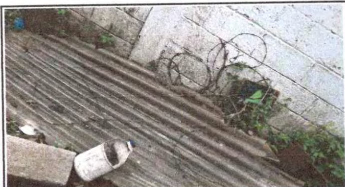
Foto 3: Reparación de cerco de alambre de pua.
