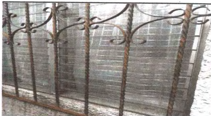
Foto 4: Mantenimiento a balcones de metal.
