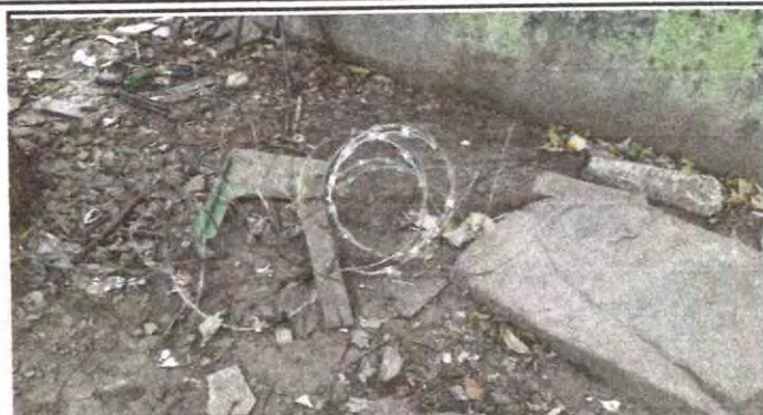
Foto 2: Reparación de cerco de alambre de pua.
