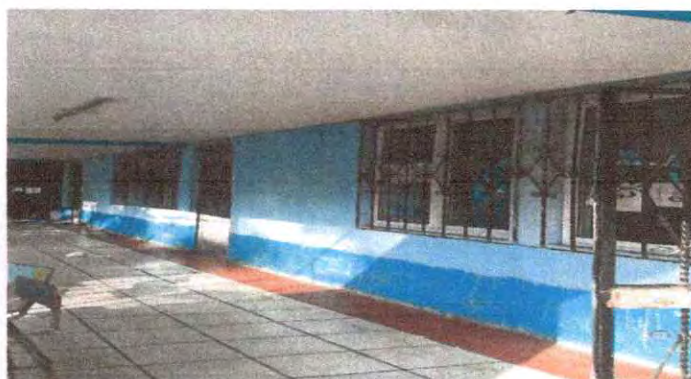
Foto 4: Pintura de muros exteriores e interiores
