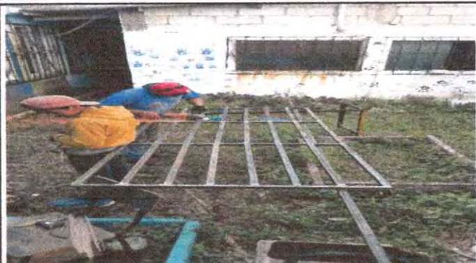
Foto 1: Fabricación e instalación de puerta de rejas
