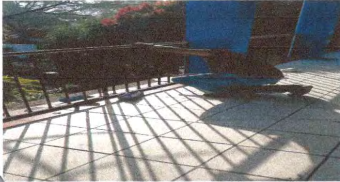
Foto 1: Mantenimiento a barandas de metal
