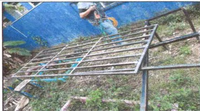
Foto 2: Fabricación e instalación de puerta de rejas
