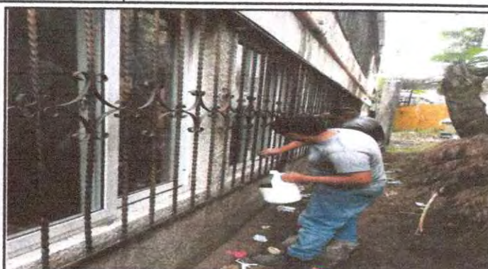
Foto 2: Mantenimiento a balcones de metal.
