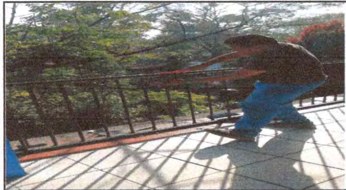
Foto 3: Mantenimiento a barandas de metal
