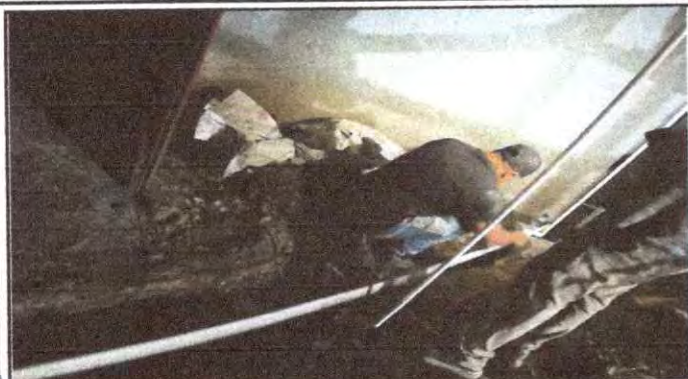
Foto 1: Instalación de tubería para agua potable
