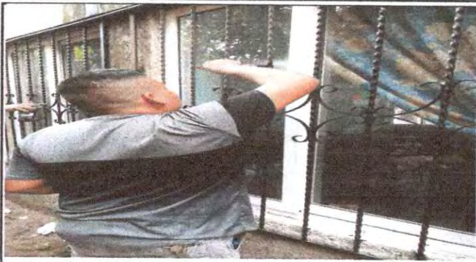
Foto1: Mantenimiento a balcones de metal.
