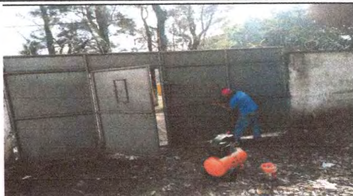
Foto 2: Mantenimiento a portones de metal
