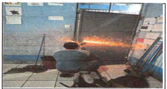
Foto 6: Sustitución de chapa
