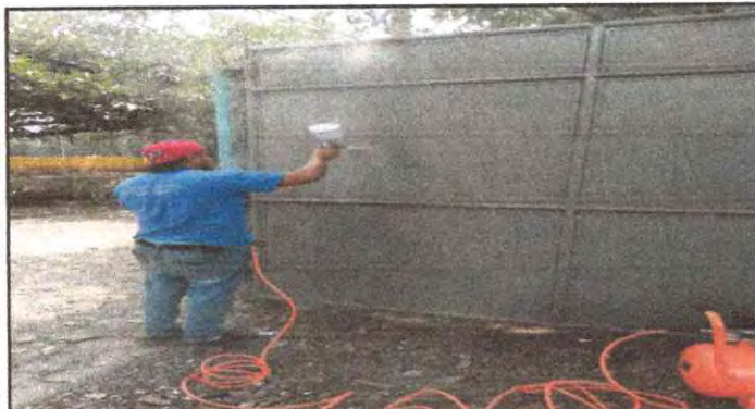
Foto 3: Mantenimiento a portones de metal
