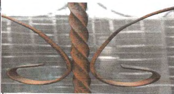
Foto 5: Mantenimiento a balcones de metal
