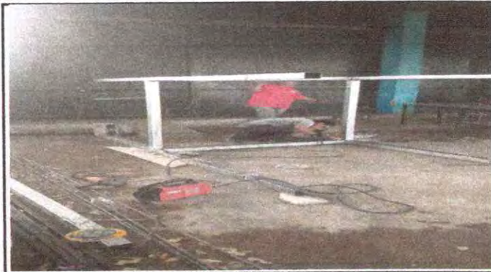
Foto 2: Instalación de estructura portante de metal
