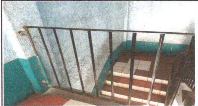
Foto 2: Mantenimiento a barandas de metal
