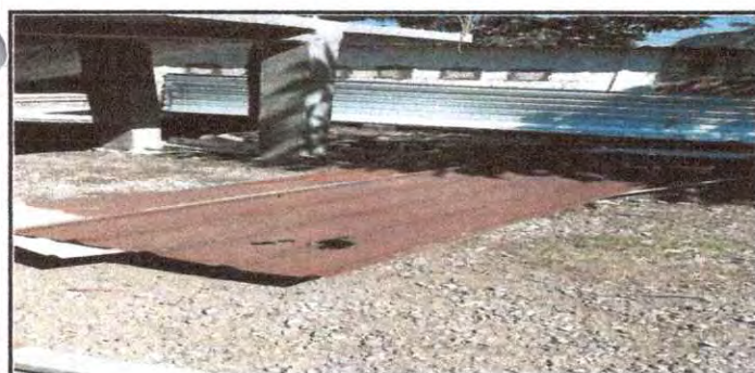
Foto 5: Sustitución de lámina, por lámina troquelada aluzinc calibre 26
