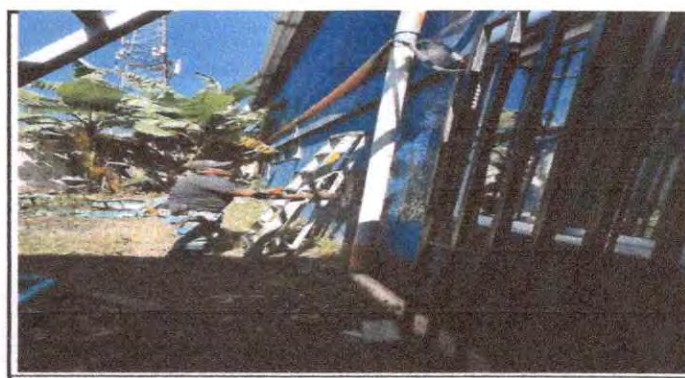
Foto 6: Reparación de bajada de agua pluvial, tubo PVC 3"
