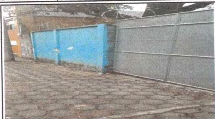
Foto 1: Reparación de cerco de alambre de pua.
