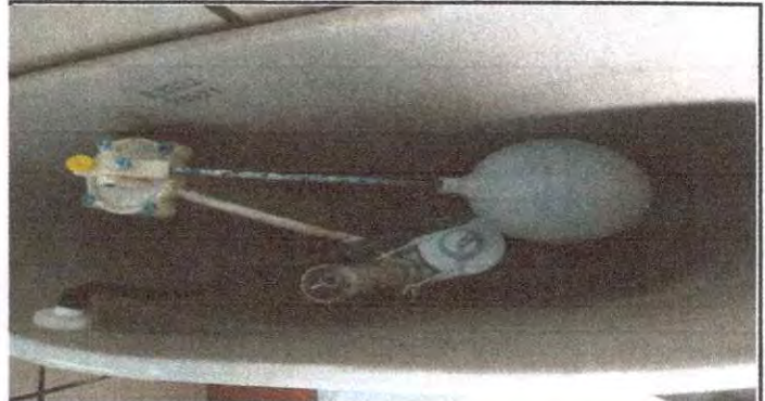
Foto 2: Sustrucción de accesorios inodoro (contra llave, tubo de abasto y tanque)
