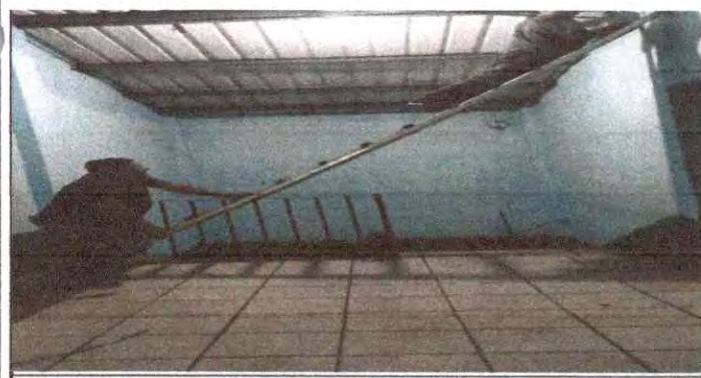
Foto 5: Pintura de muros exteriores e interiores
