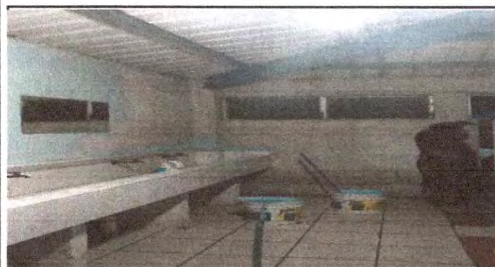
Foto 3: Pintura de muros exteriores e interiores
