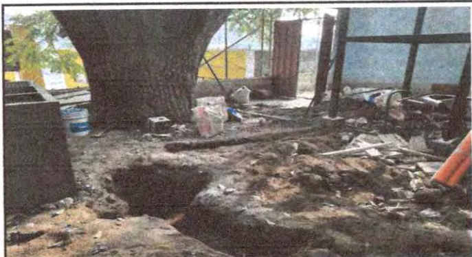
Foto 3: Instalación de tubería para agua potable
