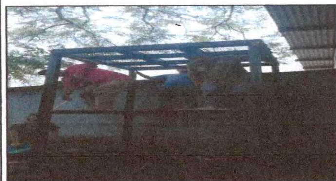
Foto 5: Instalación de estructura portante de metal
