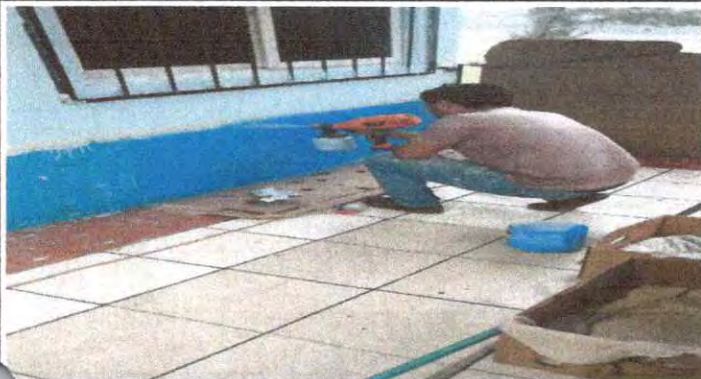
Foto 1: Pintura en muros exteriores e interiores
