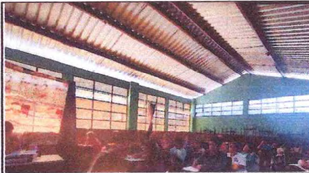
Foto 14: Sustitución de lámina por lámina troquelada aluzinc.
