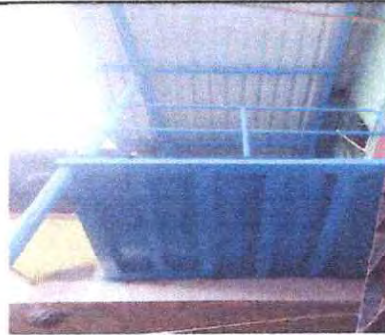
Foto 18: Mantenimiento a estructura portante de metal.
