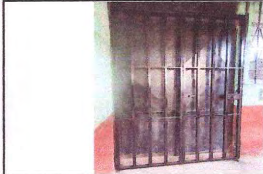
Foto 8: Mantenimiento a estructura de metal reja.
