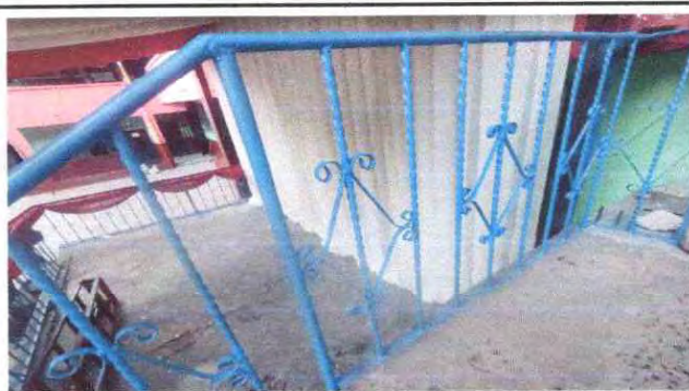
Foto 15: Mantenimiento a barandas de metal.
