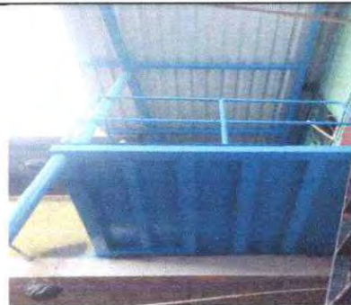
Foto 18: Mantenimiento a estructura portante de metal.
