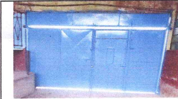
Foto 9: Mantenimiento a portón de metal.
