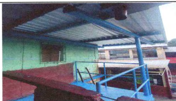
Foto 17: Mantenimiento a estructura portante de metal.
