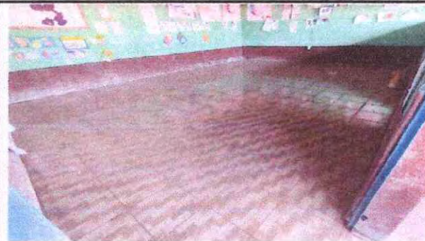
Foto 2: Sustrucción de piso cerámico.
