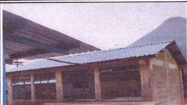
Foto13: Sustitución de lamina por lámina troquelada aluzinc.
