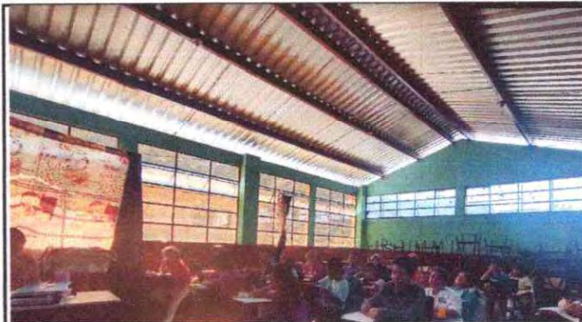
Foto 14: Sustitución de lámina por lámina troquelada aluzinc.
