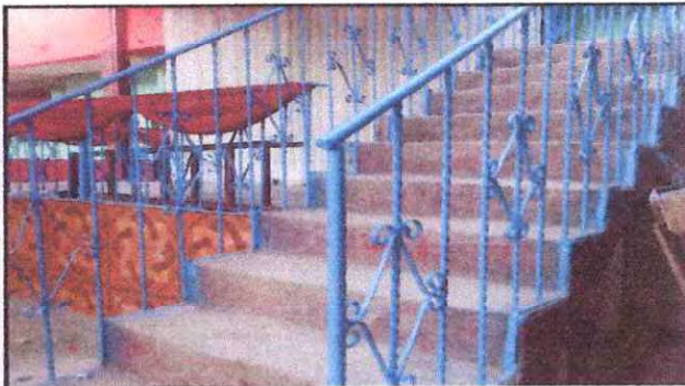
Foto 16: Mantenimiento a barandas de metal.
