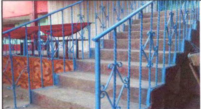
Foto 16: Mantenimiento a barandas de metal.
