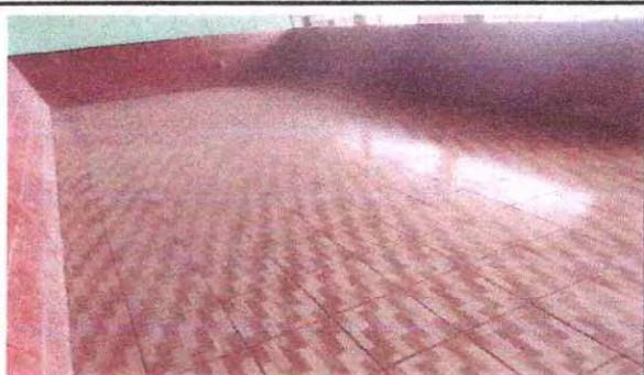
Foto 1: Sustrucción de piso cerámico.
