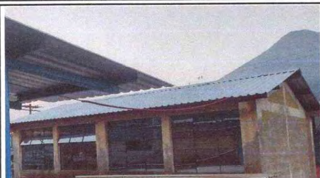
Foto 13: Sustitución de lamina por lámina troquelada aluzinc.
