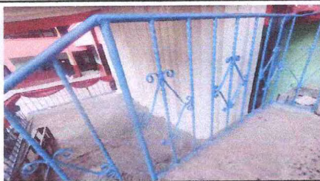
Foto 15: Mantenimiento a barandas de metal.
