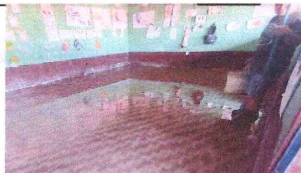
Foto 3: Sustrucción de piso cerámico.
