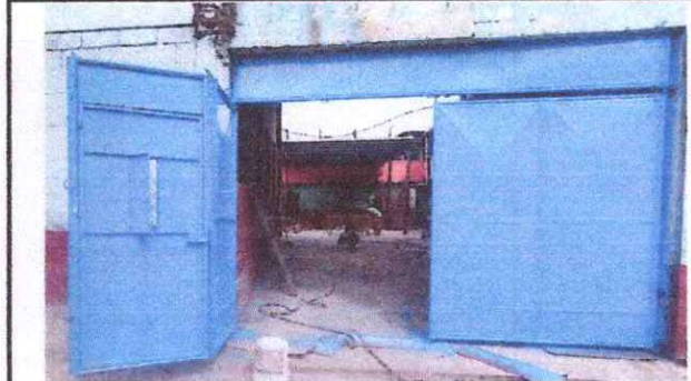
Foto 10: Mantenimiento a portón de metal.
