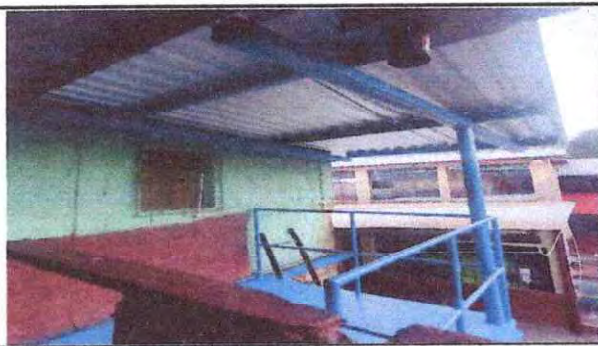
Foto 17: Mantenimiento a estructura portante de metal.
