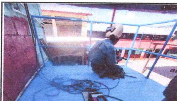
Foto 28: Mantenimiento a estructura portante de metal.
