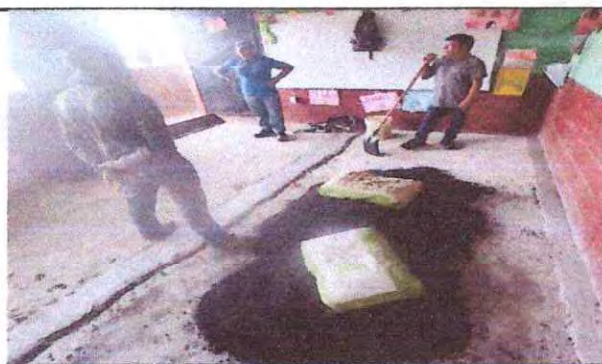
Foto 3: Sustitución de piso cerámico.
