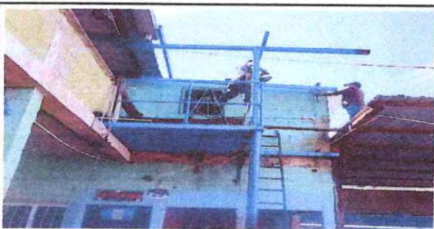
Foto 29: Mantenimiento a estructura portante de metal.
