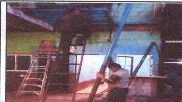
Foto 27: Mantenimiento a estructura portante de metal.
