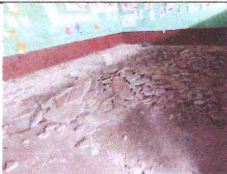
Foto1: Sustitución de piso cerámico.
