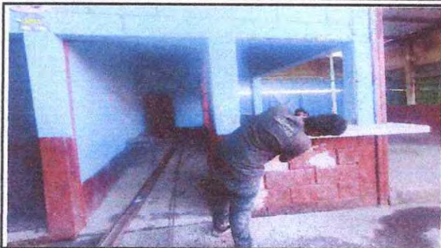
Foto 7: Sustitución de piso cerámico y azulejo.
