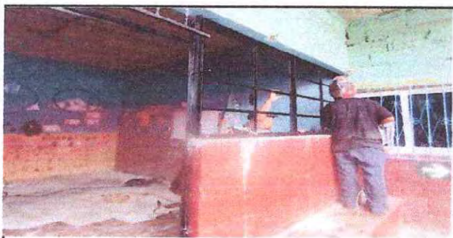
Foto 23: Mantenimiento y fabricación de estructura de metal ventana.
