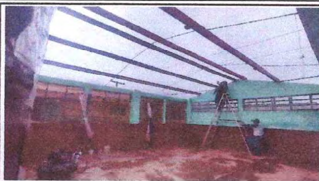
Foto 20: Sustitución de lámina por lámina troquelada aluzinc.
