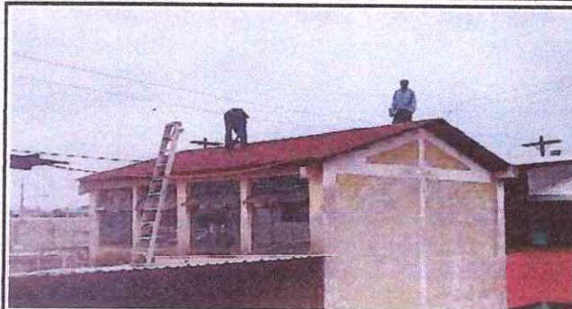
Foto 25: Sustitución de lámina por lámina troquelada aluzinc.
