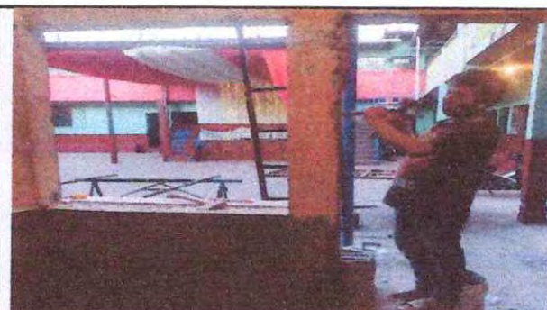
Foto 10: Sustitución de piso cerámico y azulejo.
