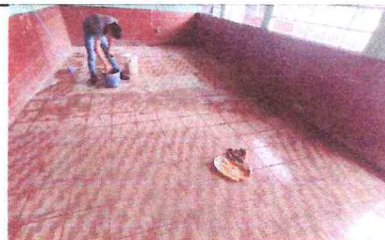
Foto 6: Sustitución de piso cerámico
