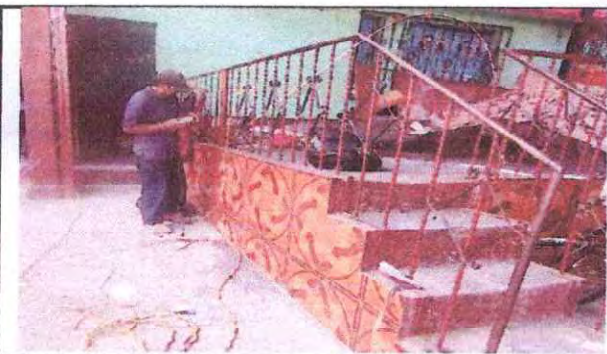
Foto 21: Mantenimiento a barandas de metal.
