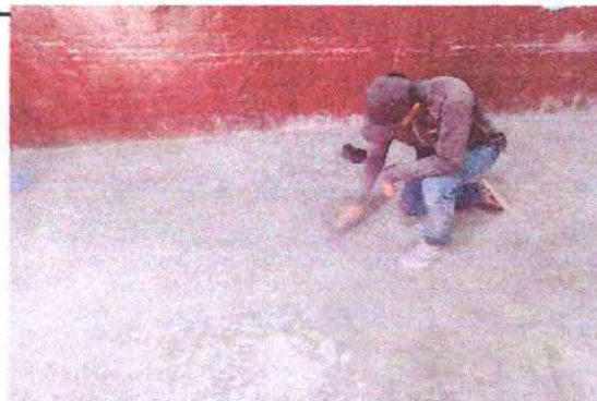
Foto 4: Sustitución de piso cerámico.
