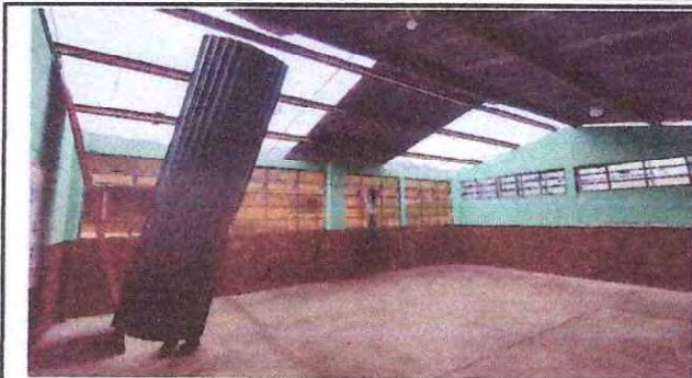
Foto 19: Sustitución de lámina por lámina troquelada aluzinc.
