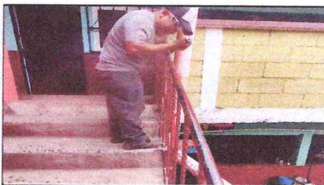
Foto 22: Mantenimiento a barandas de metal.
