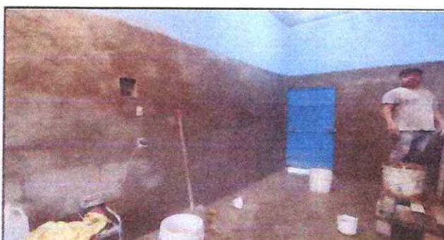
Foto 12: Sustitución de piso cerámico y azulejo.
