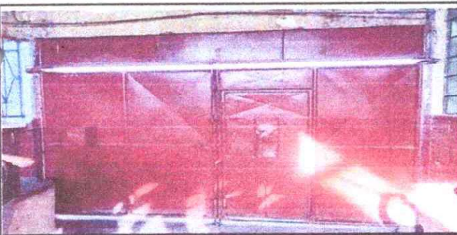
Foto 5: Mantenimiento a portones de metal.
