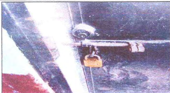
Foto 7: Sustitución de chapa.
