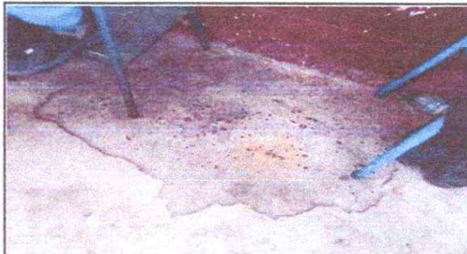
Foto 14: Sustrucción de piso cerámico en salones.
