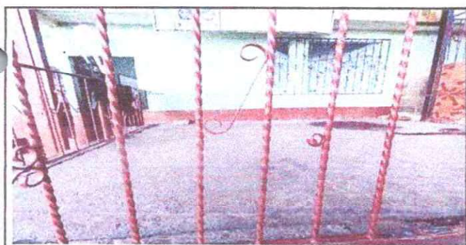
Foto 23: Mantenimiento a barandas de metal.
