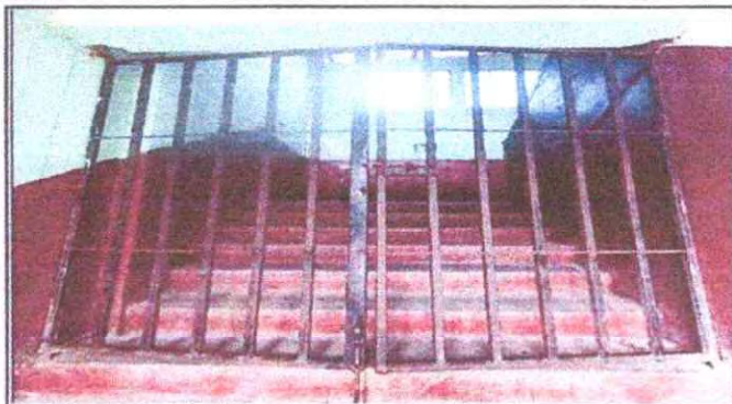
Foto 8: Mantenimiento a barandas de metal.
