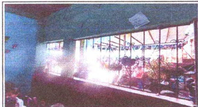
Foto 9: Mantenimiento a estructura de metal de ventana.
