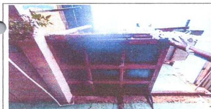
Foto 11: Reparación de plataforma de cisterna de agua.
