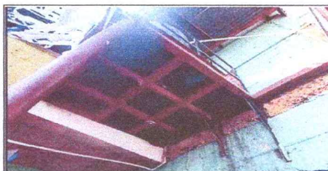
Foto 12: Reparación de plataforma de cisterna de agua
