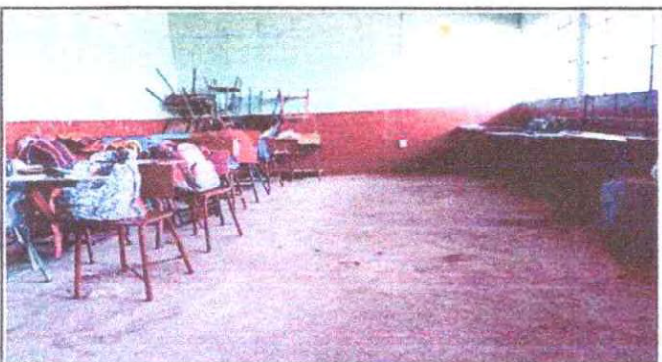
Foto 15: Sustrucción de piso cerámico en salones.
