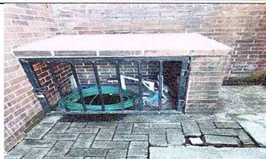
Foto 2: 18 Reparacion y mantenimiento de cisternas/ depositos de agua. 18.5 sustitucion de accesorios deposito potable. Sustitucion de Bomba de Agua.
