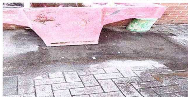
Foto 6: 14 Reparacion de drenaje y red de agua potable. 14.2 Mantenimiento de cajas de registro. 14.3 sustitucion de tuberia PVC linea principal. 14.4 sustitucion de tuberia PVC linea aguas pluviales. 14.5
