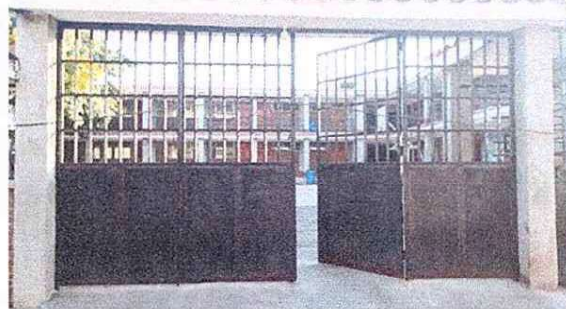
Foto 4: 12 Mantenimiento de Porton. 12.1 Mantenimiento a portones de metal.
