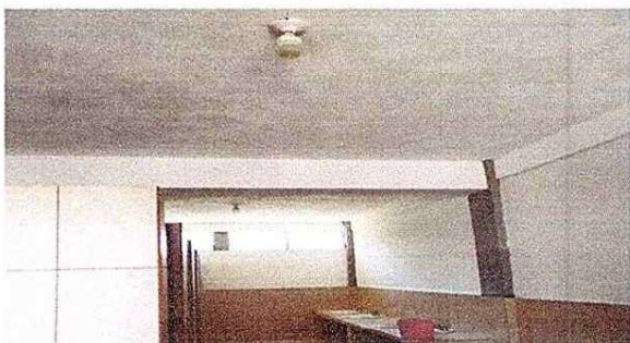
Foto 1: 17 Reparacion de sistema electrico. 17.4 Sustitucion de focos ahorradores. 17.7 Sustitucion de interruptores dobles. 17.8 Sustitucion de tomas de corriente dobles. 17.11 Reparacion de cableado electrico. 17.12
