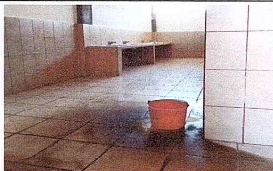
Foto 2: 6 Piso Reparacion de piso de torta de concreto. 6.1 Reparacion de piso ceramico
