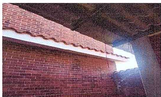
Foto 1: 1 Cubierta de lamina. 1.1 sustitucion de lamina troquelada aluzinc calibre 26. 1.2 sustitucion de capote de lamina para lamina troquelada. 1.3 sustitucion de elementos de fijacion
