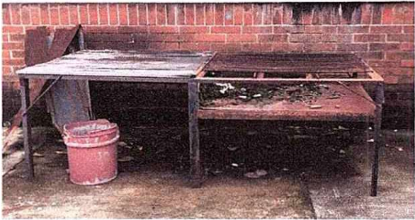
Foto 7: Estufa en mal estado, Region 20.2 (Sustitución de estufa rural completa incluye chimenea y plancha de metal)
