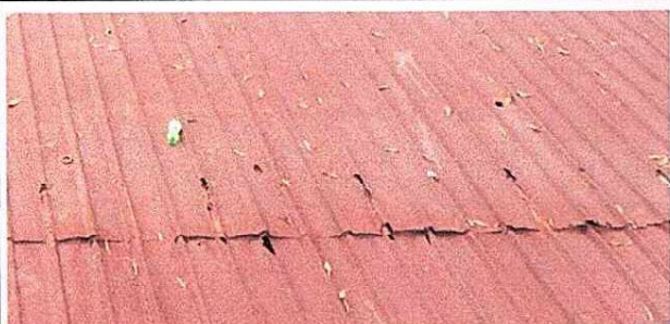
Foto 1: Lamina en mal estado, Region 1.1 (Sustitución de lamina por lamina troquelada aluzinc calibre 26) Region 19.8 (Instalación de lamina troquelada aluzinc) Region 19.20 (Desinstalación de lamina existente)
