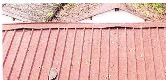
Foto 2: Capote en mal estado, Region 1.2 (Sustitución de capote de lamina para lamina troquelada) Region 1.3 (Sustitución de elementos de fijación)
