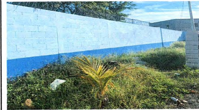
FOTO 10. 21.1 Repello en muro.
