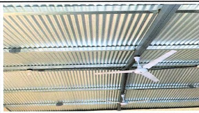
FOTO 2. AULA 4. 1.3 Sustitución de elementos de fijación
