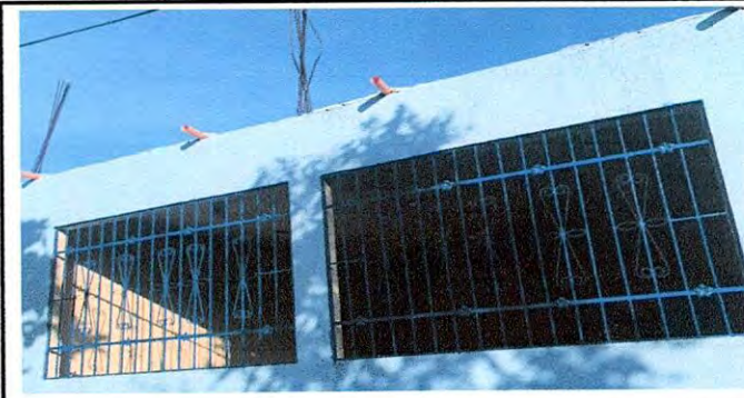
FOTO 6. AULA. 3 5.6 Sustitución de balcones de metal.
