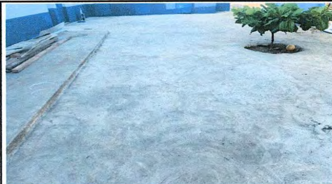
Foto 8. 6.5 Sustitución de piso de torta de concreto.
