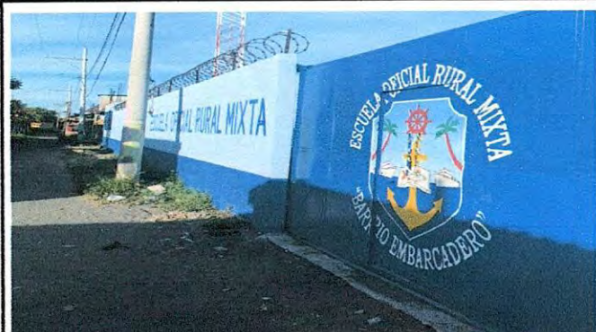
FOTO 9. 9.1 Pintura en muros exteriores e interiores.
