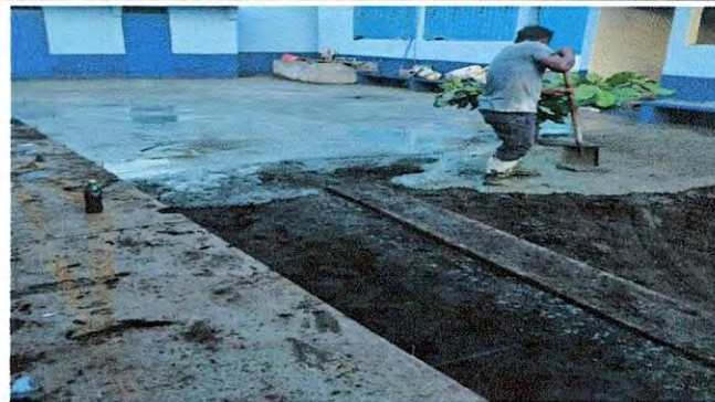
Foto 8. 6.5 Sustición de piso de torta de concreto.
