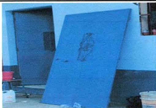
FOTO 5: AULA 4. 4.5 Sustitución de porton de metal.
