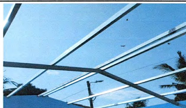
FOTO 2. AULA 4. 1.3 Sustitución de elementos de fijación
