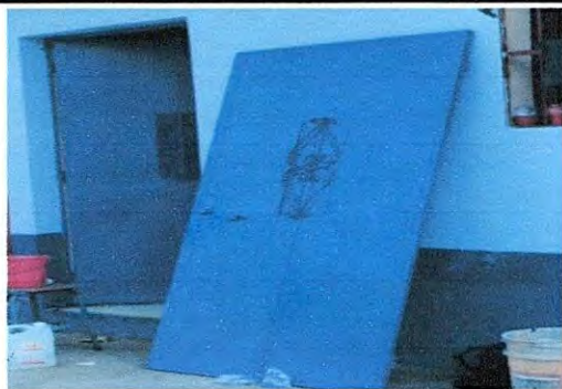
FOTO 5: AULA 4. 4.5 Sustitución de porton de metal.
