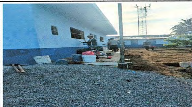
FOTO 10. 21.1 Repello en muro.
