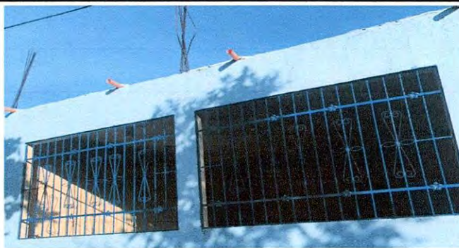
FOTO 6. AULA 3. 5.6 Sustitución de balcones de metal.
