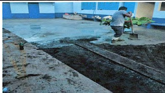
Foto 8. 6.5 Sustición de piso de torta de concreto.
