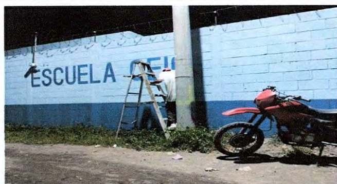
FOTO 9. 9.1 Pintura en muros exteriores e interiores.
