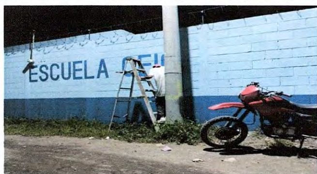
FOTO 9. 9.1 Pintura en muros exteriores e interiores.
