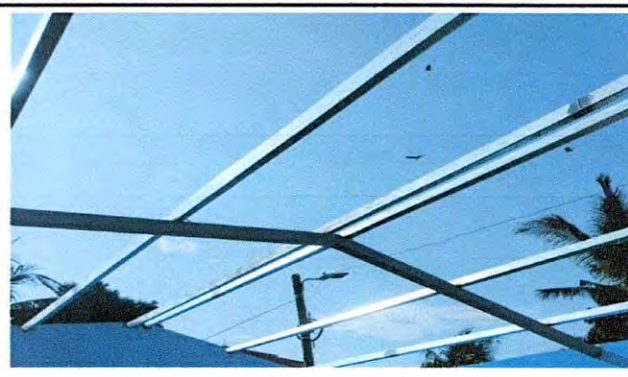
FOTO 2. AULA 4. 1.3 Sustitución de elementos de fijación
