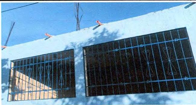
FOTO 6. AULA 3. 5.6 Sustitución de balcones de metal.
