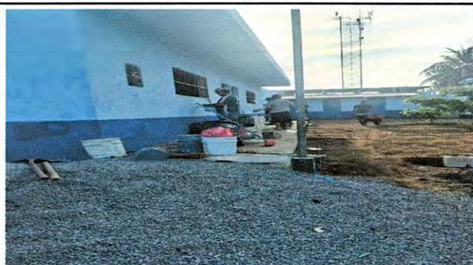
FOTO 10. 21.1 Repello en muro.
