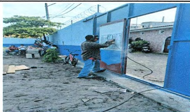
FOTO 4. SANITARIOS 4.1 Mantenimiento a estructura (lijado, cambio de tubo, cepillado, sujeciones, aplicación de pintura.)
